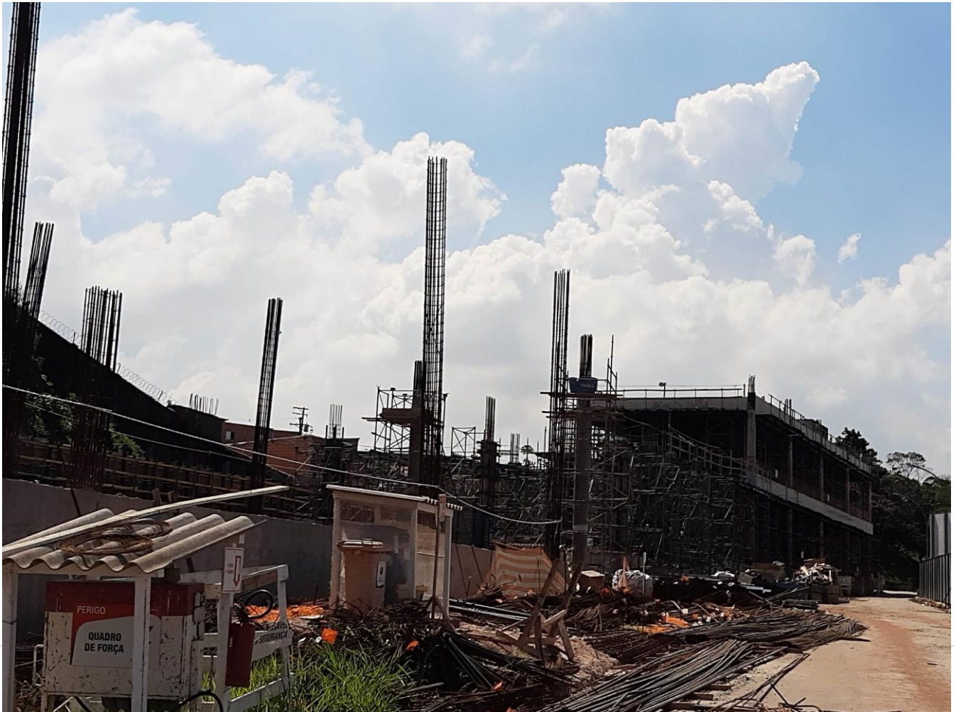
Foto 03: Vista do canteiro de obras
