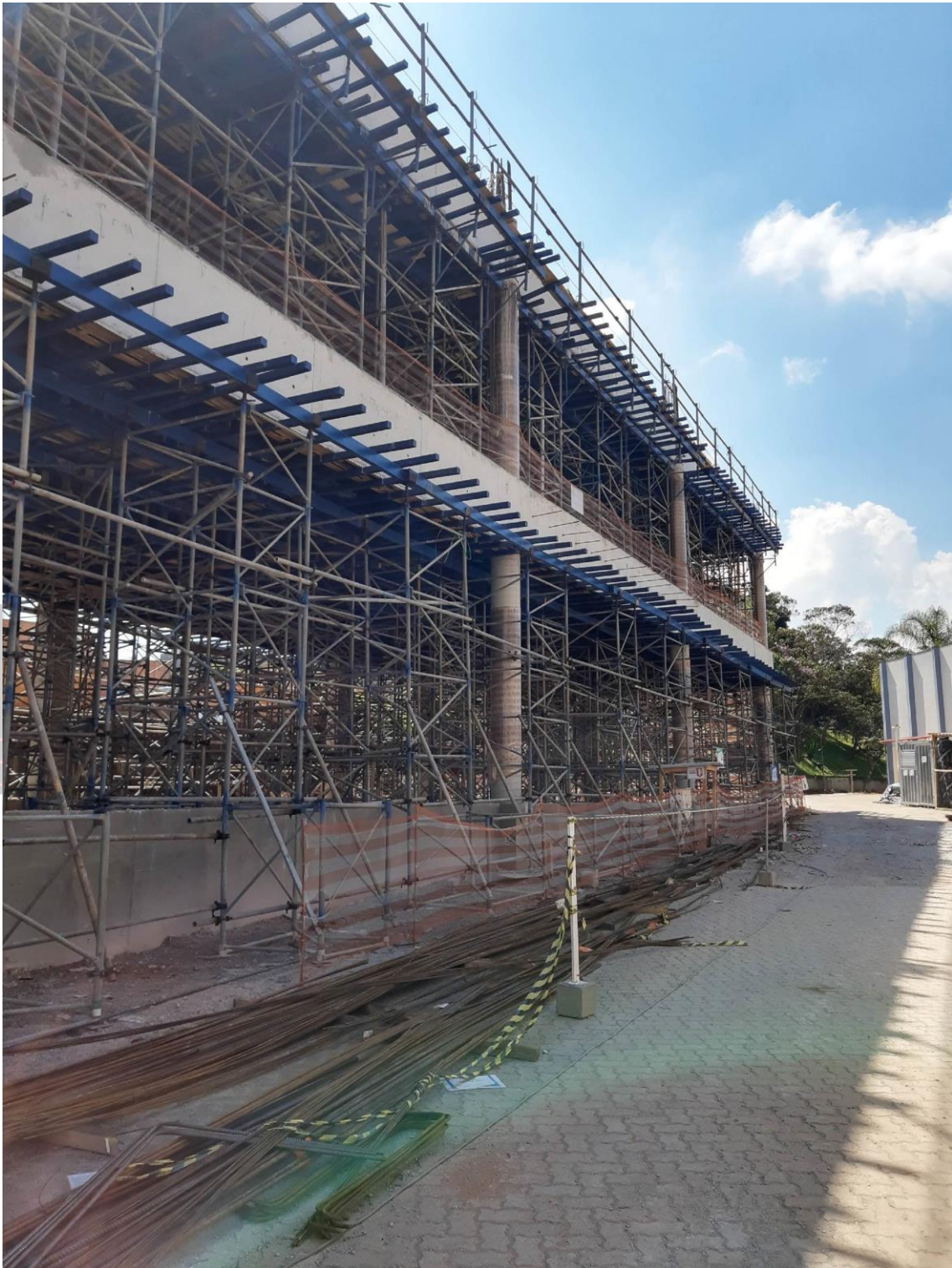
Foto 02: Vista do canteiro de obras
