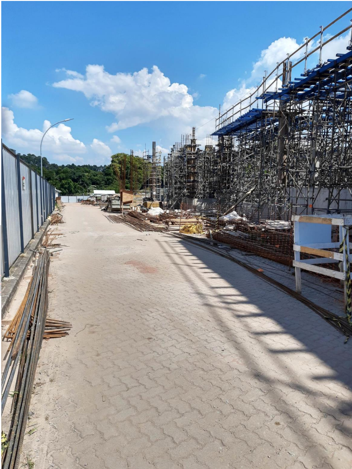
Foto 01: Vista de parte da edificação
