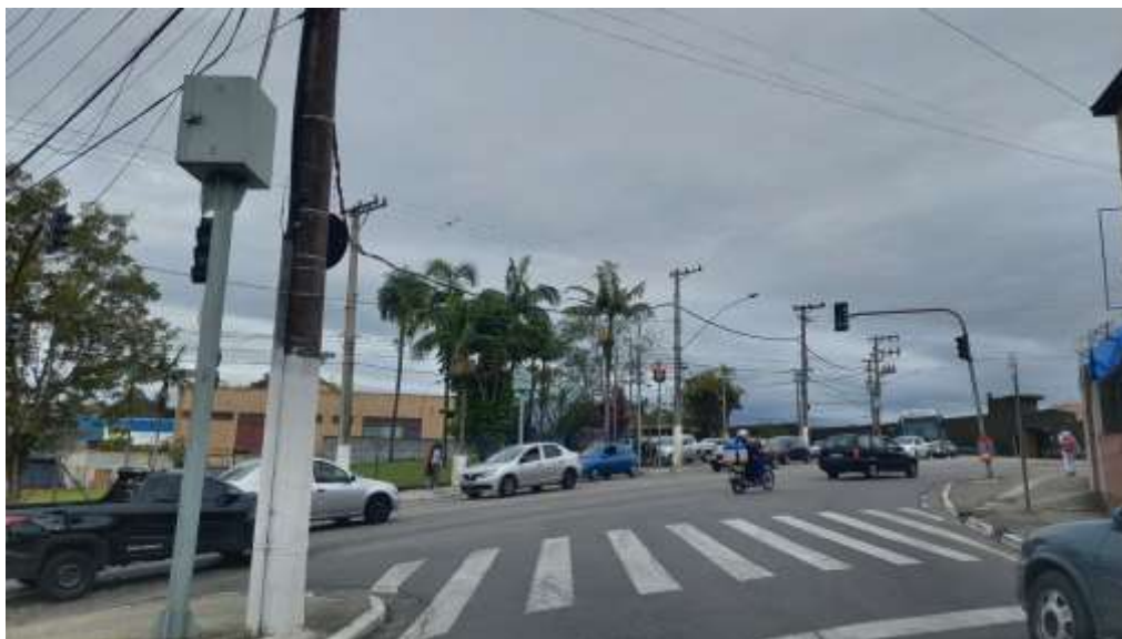
Rua Wadia Jafete Assad – umas das vias que dá acesso ao empreendimento
