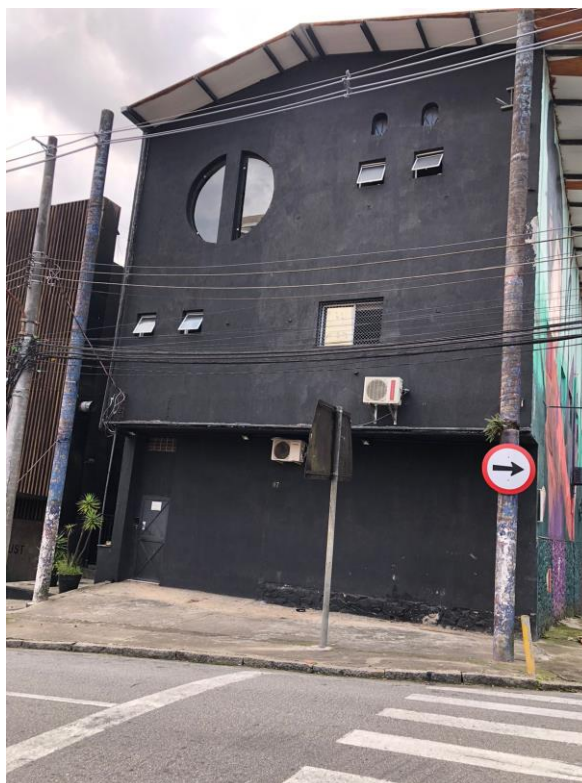
Foto 02 – Vista frontal do prédio administrativo
