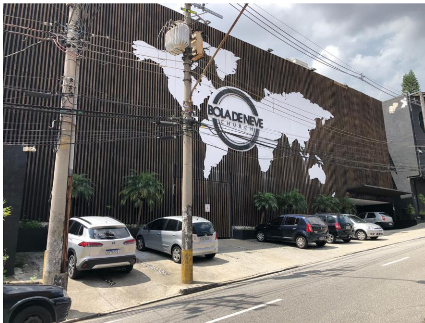
Foto 01- Vista da fachada frontal
