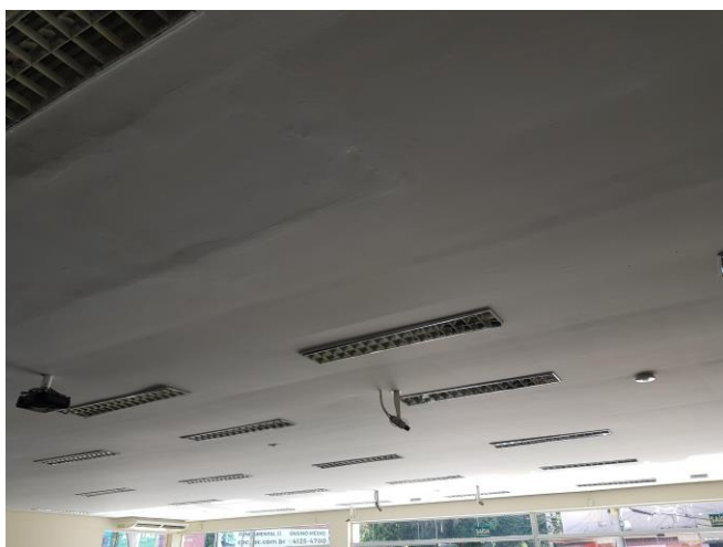
Figura 13 - Forro em gesso acartonado, atenua o ruído interno e externo
