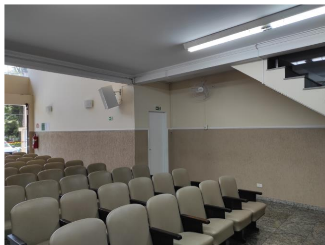
Figura 16 - paredes em alvenaria, atenuam o ruído int. e externo
