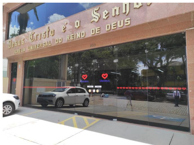
Figura 11 - Portas de vidro, atenuam o ruído interno e externo
