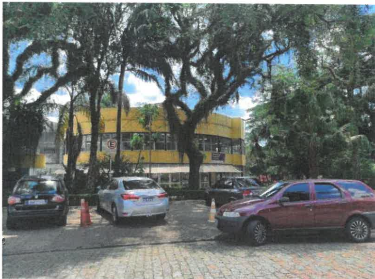
Vista frente do imóvel
