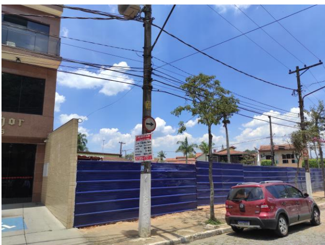
Figura 9 - Entorno imediato, obra
