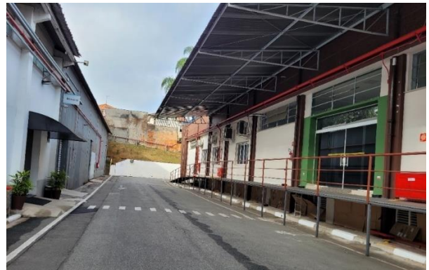
Vista interna do Empreendimento Comercial. Fonte: Foto extraída do local
