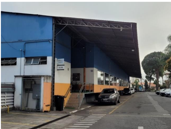
Vista interna do Empreendimento Comercial. Fonte: Foto extraída do local
