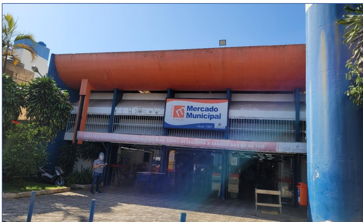
Vizinhança Mediata – Avenida Caminho do Mar – Mercado Municipal de Rudge Ramos Foto tirada no local.
