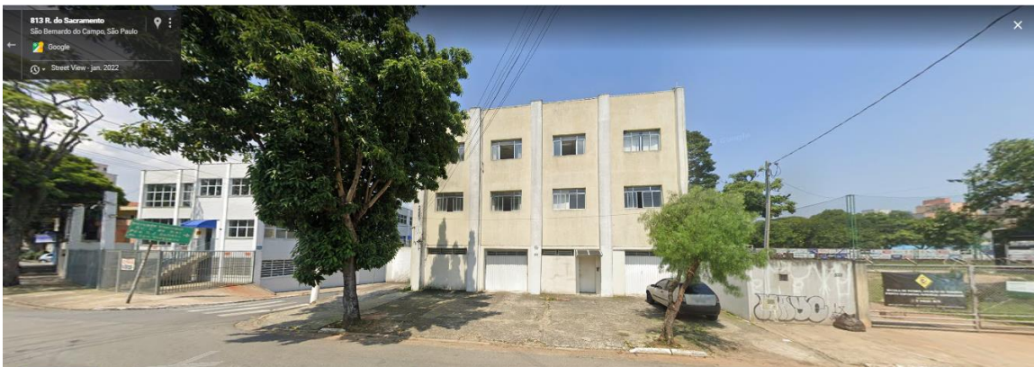
Vizinhança Imediata – Rua do Sacramento esquina com Rua Jair Fongaro - edificação industrial Fonte: Google
