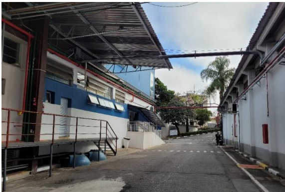
Vista Interna do Empreendimento. Fonte: Foto extraída do local
