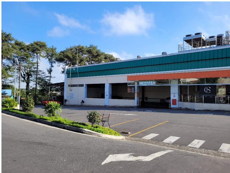
Vista do Supermercado – área de carga e descarga do supermercado e gerador. Fonte: Foto extraída do local
