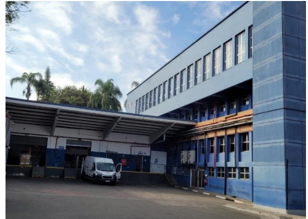
Vista interna do Empreendimento Comercial. Fonte: Foto extraída do local
