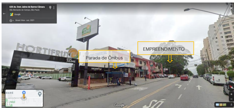
Parada de Ônibus Avenida Dom Jaime de Barros Câmara – Mesmo sentido do terreno. Fonte:Googlemaps
