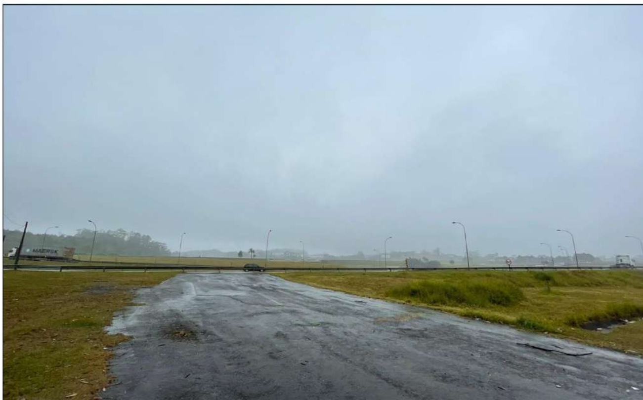
IMAGEM 07 – SAÍDA DE ACESSO PARA O RODOANEL MÁRIO COVAS/INÍCIO DO TRECHO SOB CONCESSÃO SPMAR.
