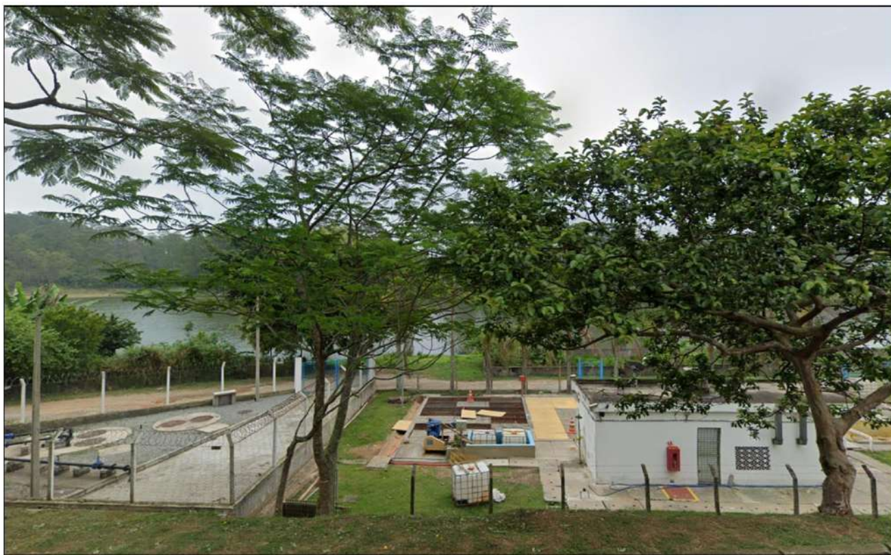
IMAGEM 12 – MONITORAMENTO SABESP - COMPANHIA DE SANEAMENTO BÁSICO DO ESTADO DE SÃO PAULO.
