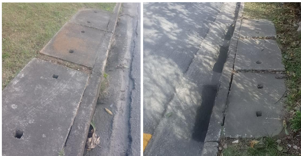
Figura 34: Bocas de lobo nas vias da AVM. Fonte: Master Ambiental, 2022.
