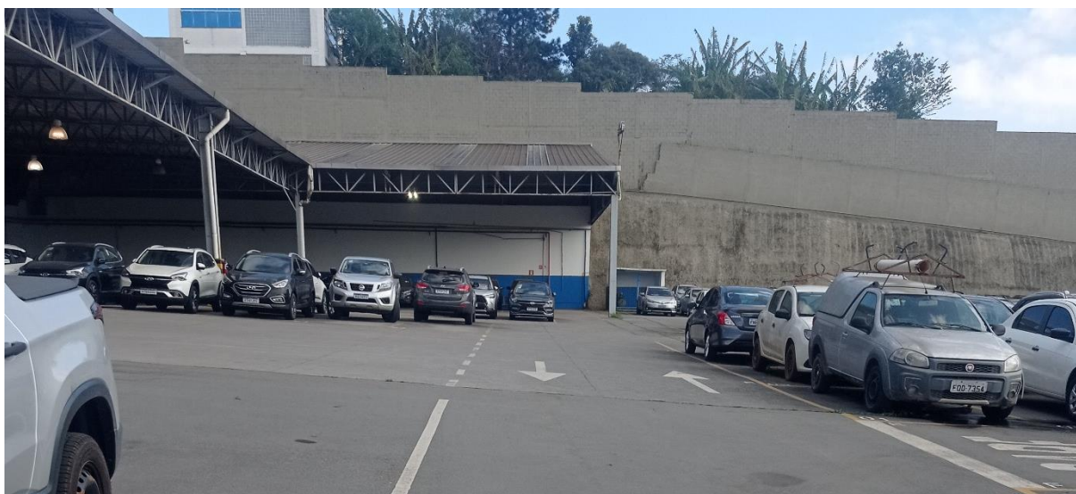
Figura 48: Área de carga e descarga do empreendimento. Fonte: Master Ambiental, 2022.
