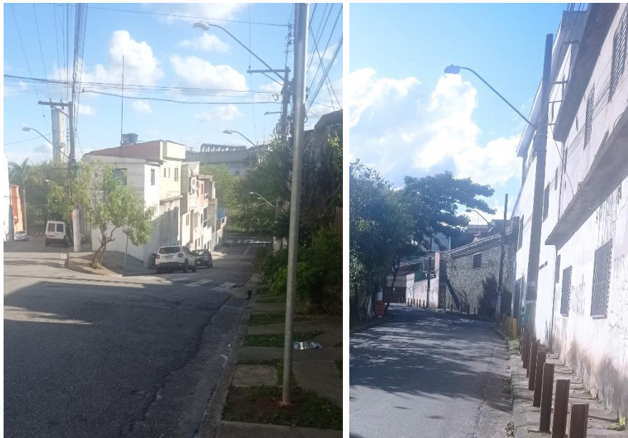
Figura 26: Iluminação pública na AVM. Fonte: Master Ambiental, 2022.
