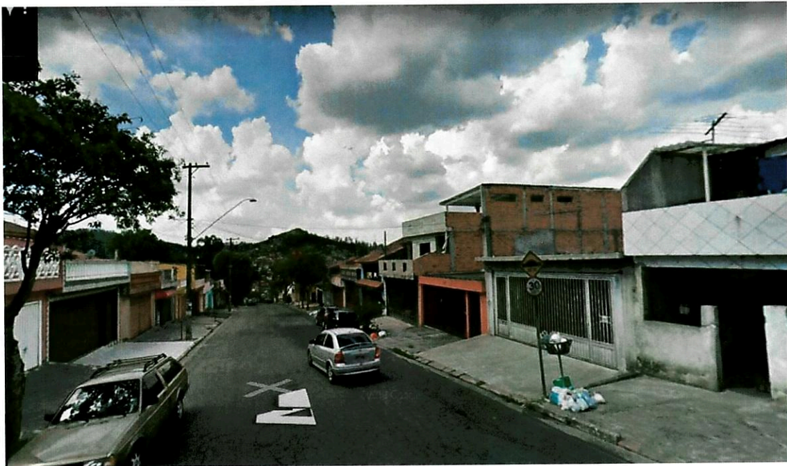
AVENIDA SERGIO TREVISAN: PAVIMENTADA E USO RESIDENCIAL UNIFAMILIAR.
