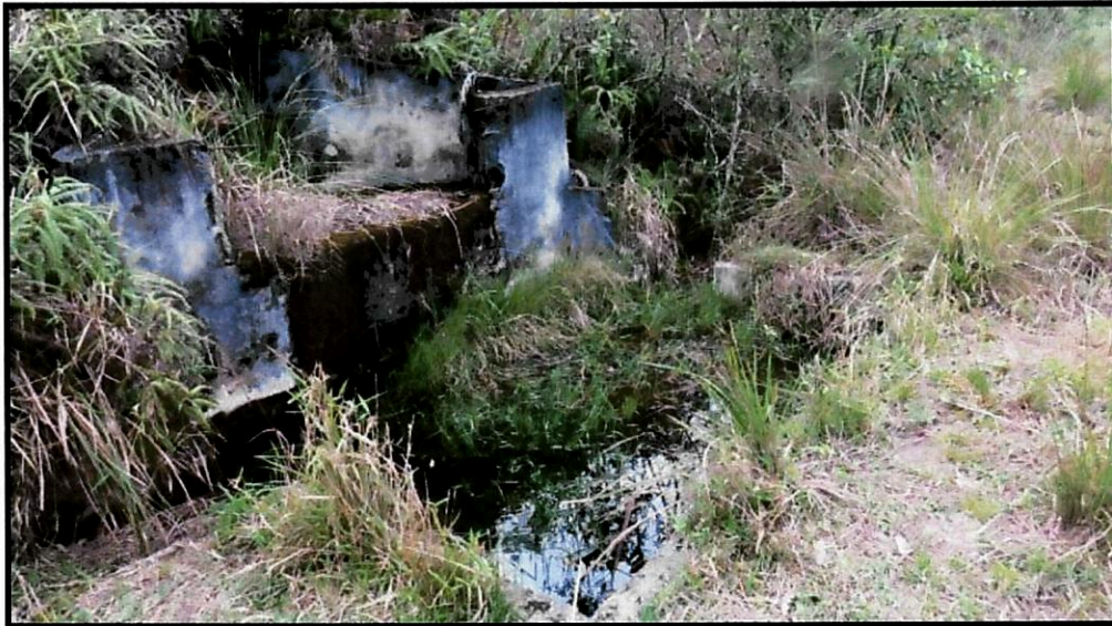
Foto 16: Apresenta mais ruínas de sistema de drenagem, indicando caixa com grande volume de água
