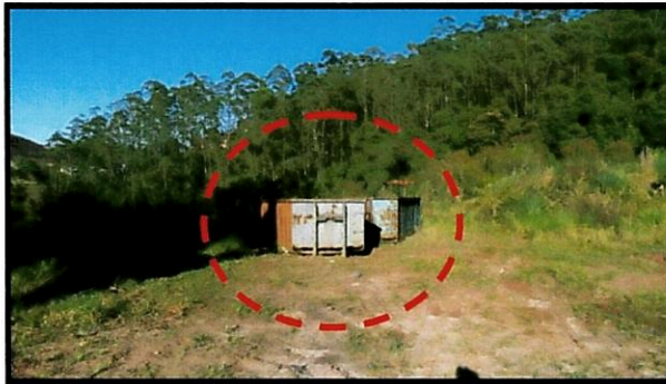
Foto 13: Apresenta caçambas de lixo no interior do terreno.
