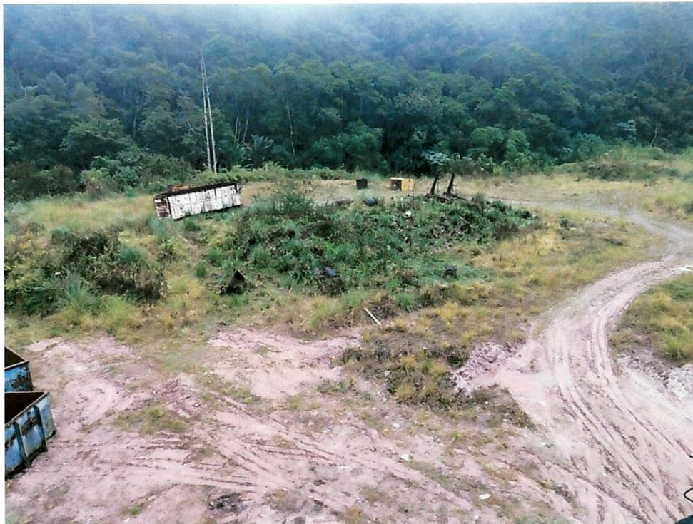
Foto 4 – Vista de cima da construção existente
