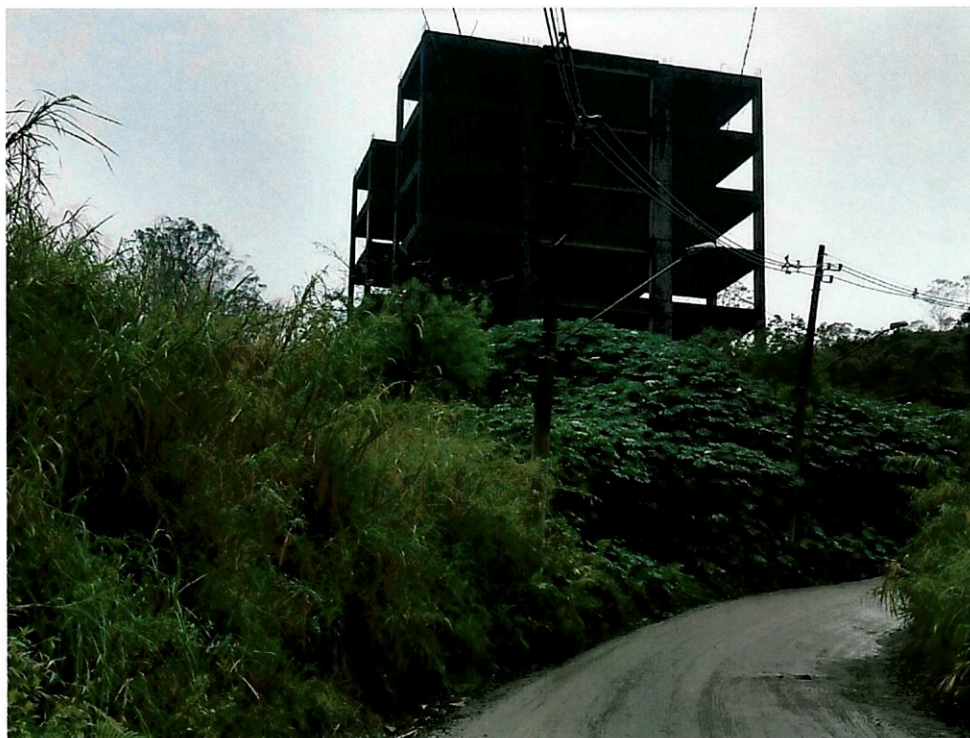
Foto 2 – Estrada do montanhão para o interior do imóvel – Det. Const. Exist.
