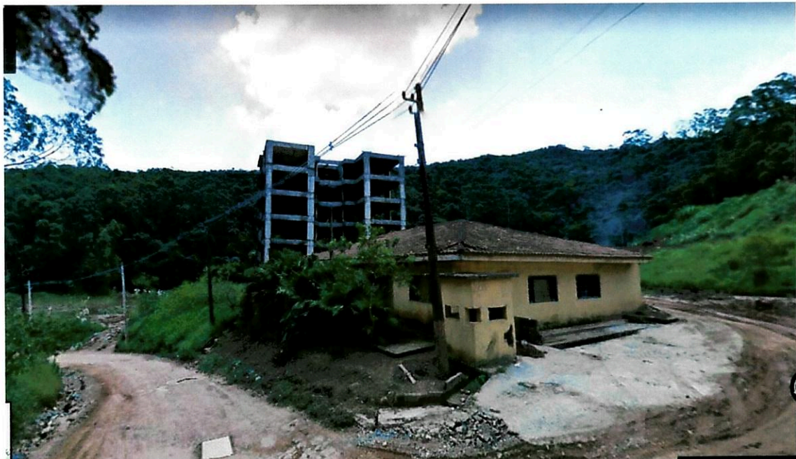
ENTRADA ATUAL DO IMÓVEL: EM SEGUNDO PLANO, EDIFICAÇÃO REMANESCENTE DE PROJETO HABITACIONAL PARALIZADO.
