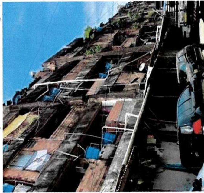
Imagens 2 – Edificações e viário entre os galpões
