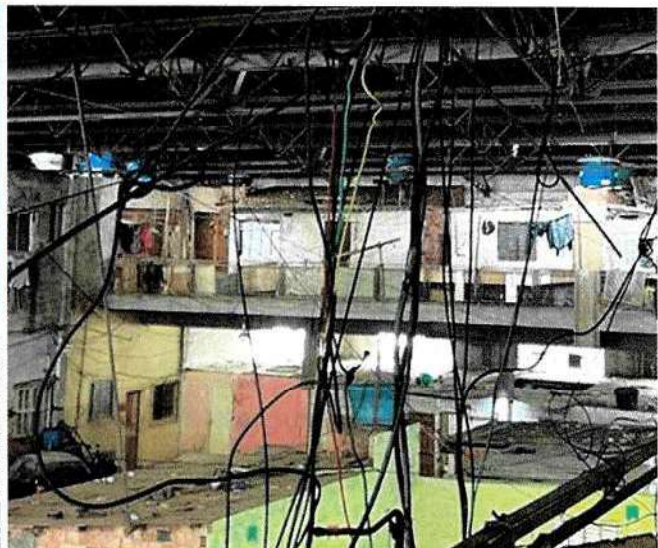
Ocupação no interior do galpão
