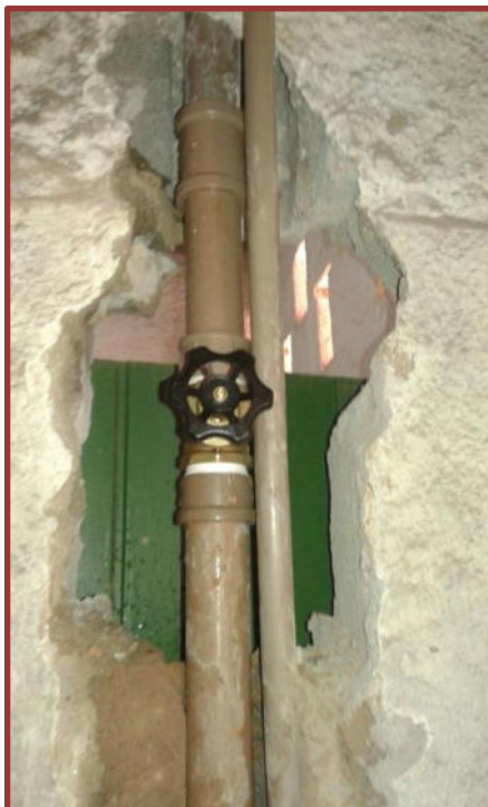
Figura 23 – Instalação de registro de gaveta em unidade esportiva
