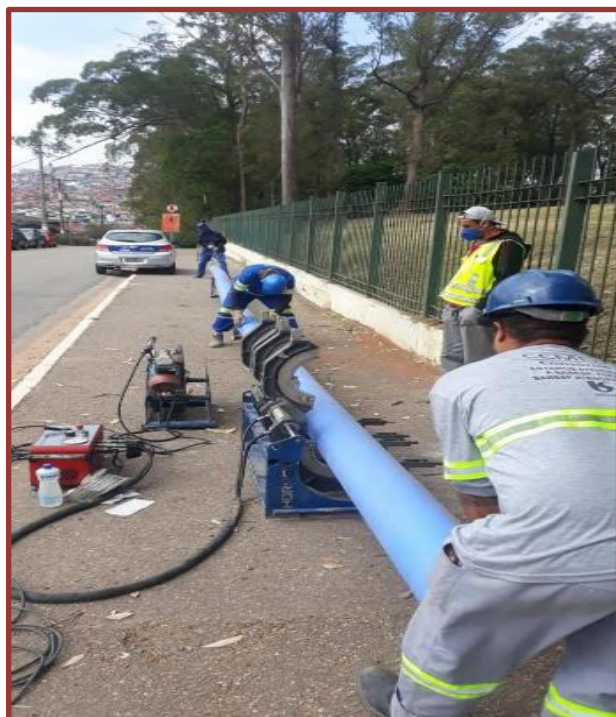
Figura 5: Tubulação soldada para ser introduzida no furo
