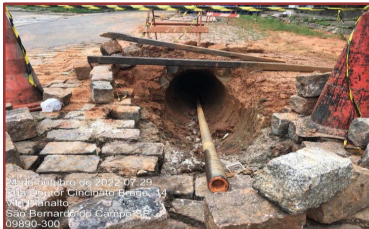
Figura 4: Resultado Perfuratriz utilizada na substituição das redes d'água
