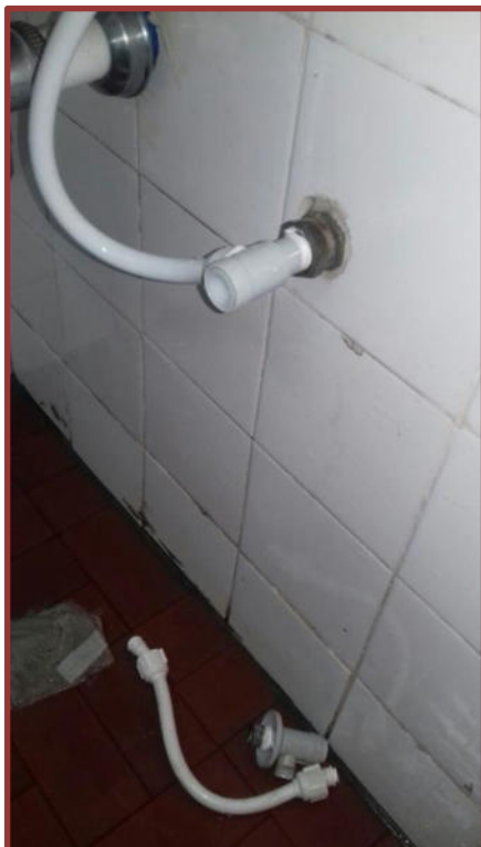
Figura 21 – Substituição de engate flexível de lavatório em UBS
