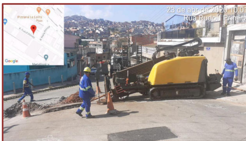
Figura 2: Perfuratriz utilizada na substituição das redes d'água
