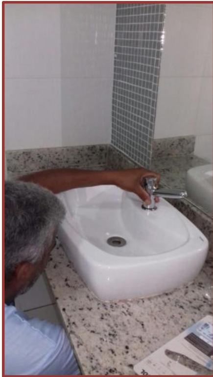
Figura 15 – Instalação de torneiras de fechamento automático tipo mesa em unidade escolar
