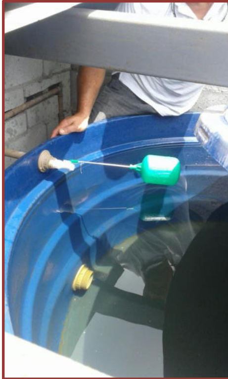
Figura 22 – Substituição de torneira de boia em unidade esportiva
