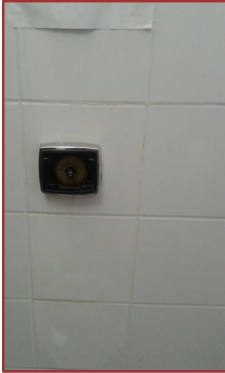
Figura 20 – Reparo e regulagem de válvula de descarga em unidade escolar
