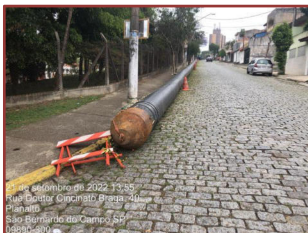
Figura 3: Tubo guia utilizado na perfuração
