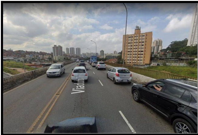
Viaduto Tereza Delta Fonte Google Map
