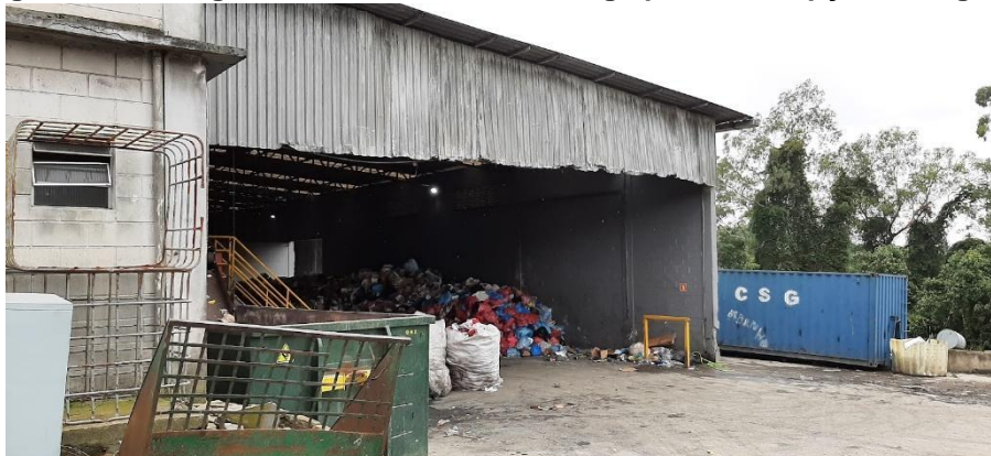
Figura 80: Vista geral externa da entrada do galpão de recepção e triagem.
