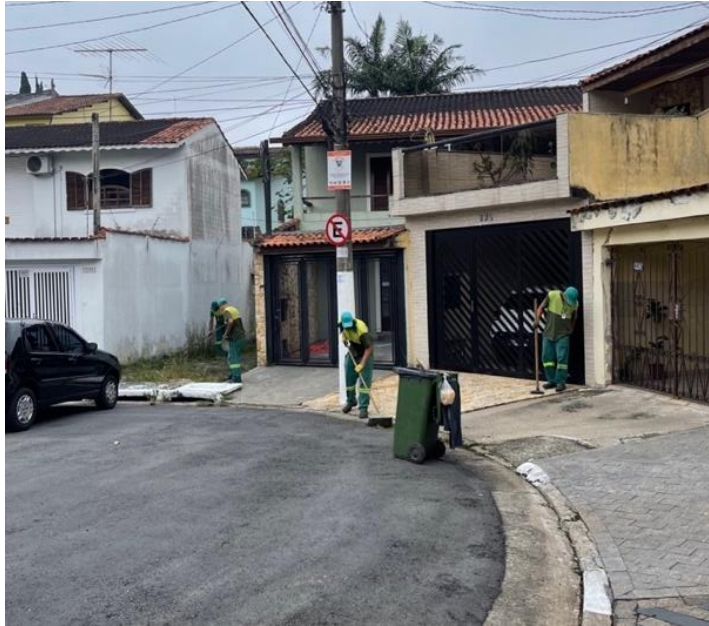
Figura 51: Serviços de Capina em execução.
