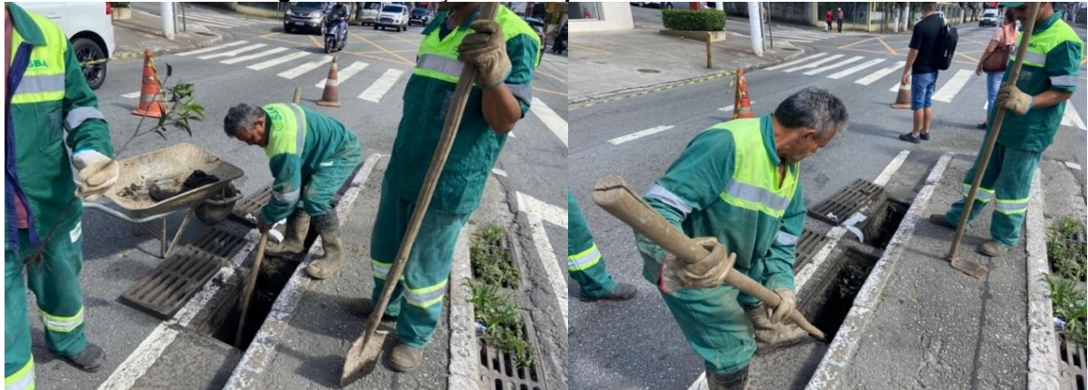
Figura 57: Serviços de Limpeza de Bocas-de-lobo.
