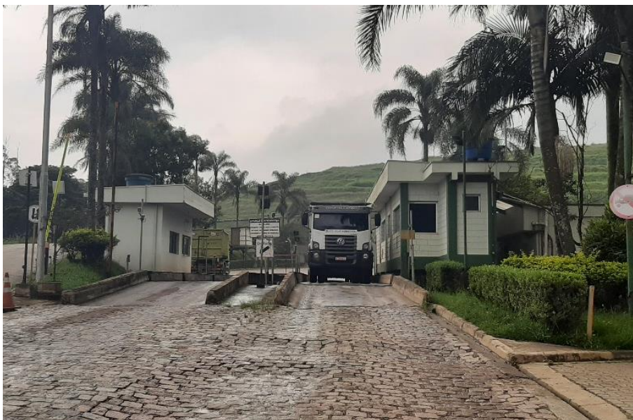
Figura 113: Balança do Aterro Sanitário LARA.
