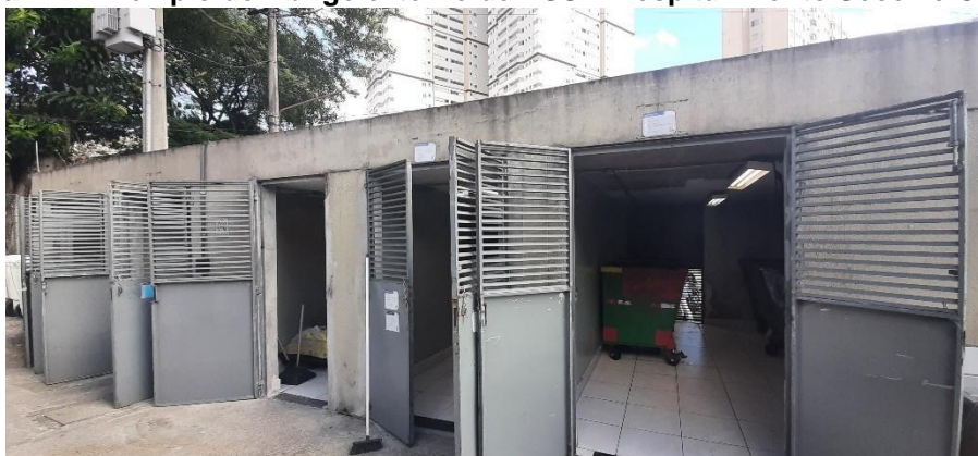
Figura 121: Exemplo de Abrigo externo de RSS – Hospital Pronto Socorro Central.
