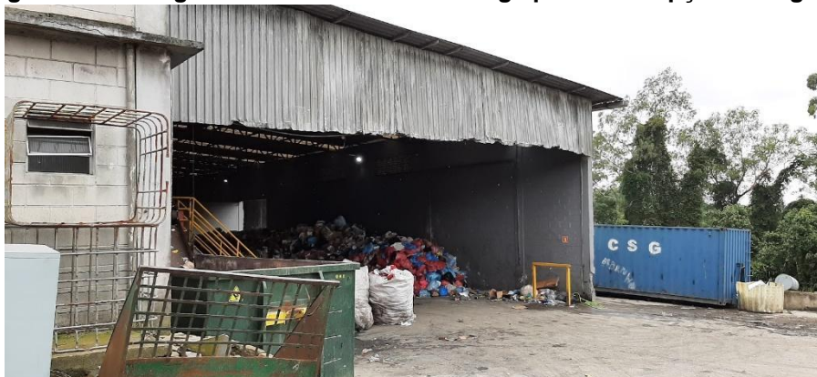
Figura 80: Vista geral externa da entrada do galpão de recepção e triagem.
