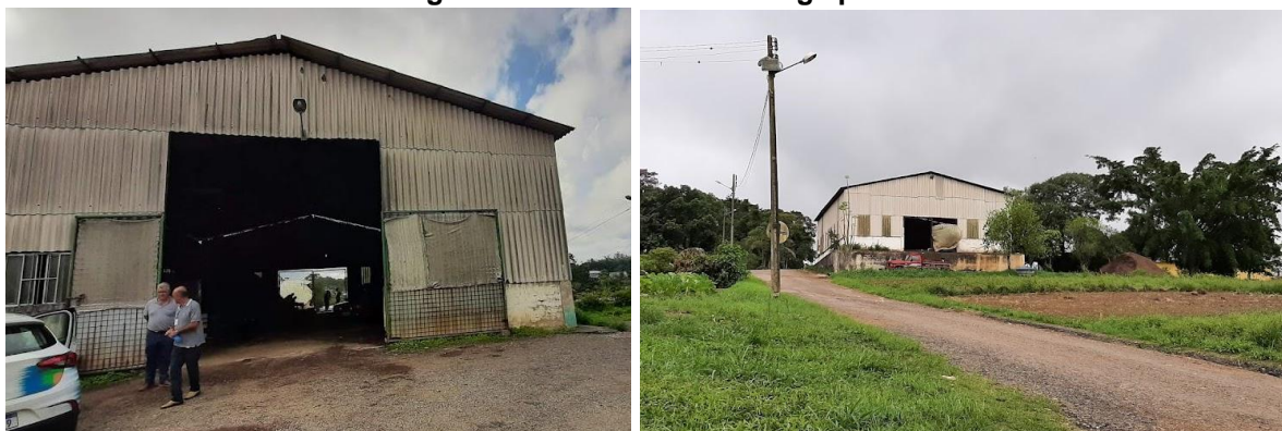
Figura 109: Vista externa do galpão.
