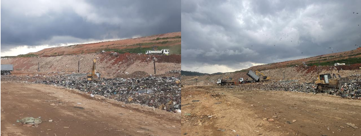
Figura 115: Células do Aterro Sanitário Lara.
