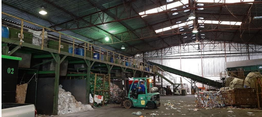
Figura 71: Vista geral da linha de triagem manual e área de estocagem.
