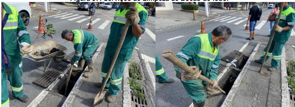
Figura 57: Serviços de Limpeza de Bocas-de-lobo.
