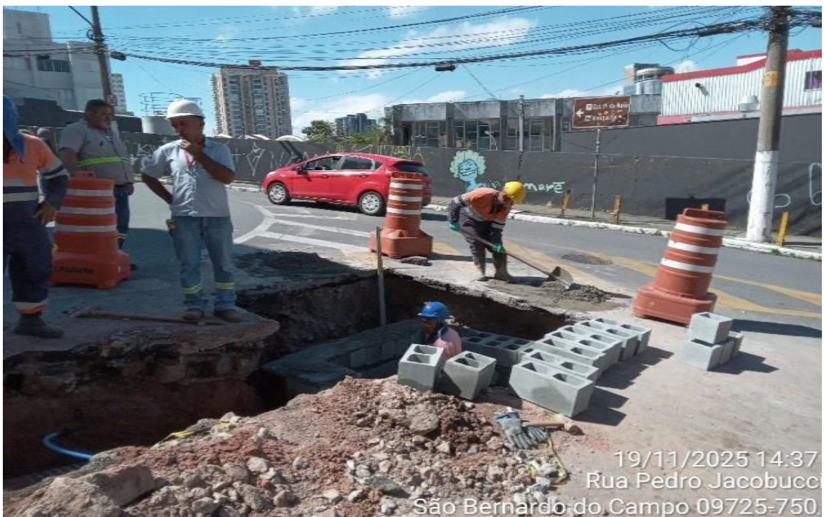
Rua Olavo Bilac – Execução de PV
