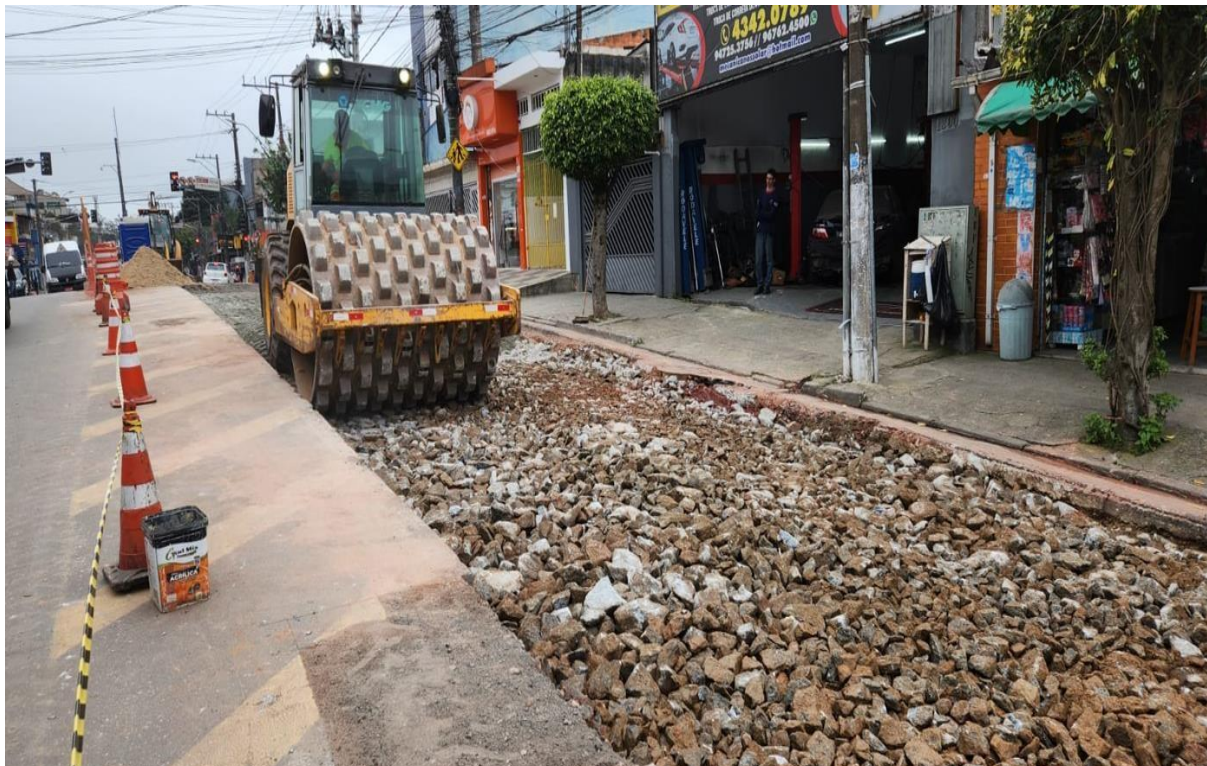
Reforço de Base no pavimento da Estrada do Pony Club – Jd.das Orquídeas
