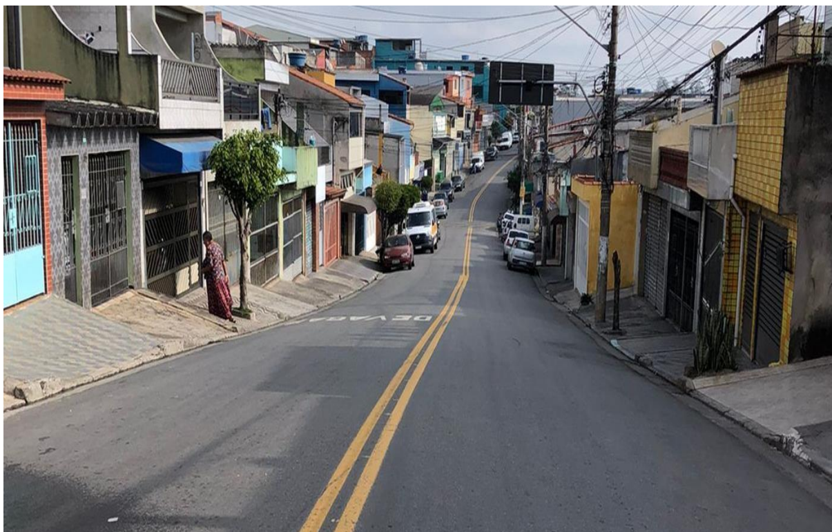
Pavimentação e Sinalização Horizontal na Rua Almeida Durão
