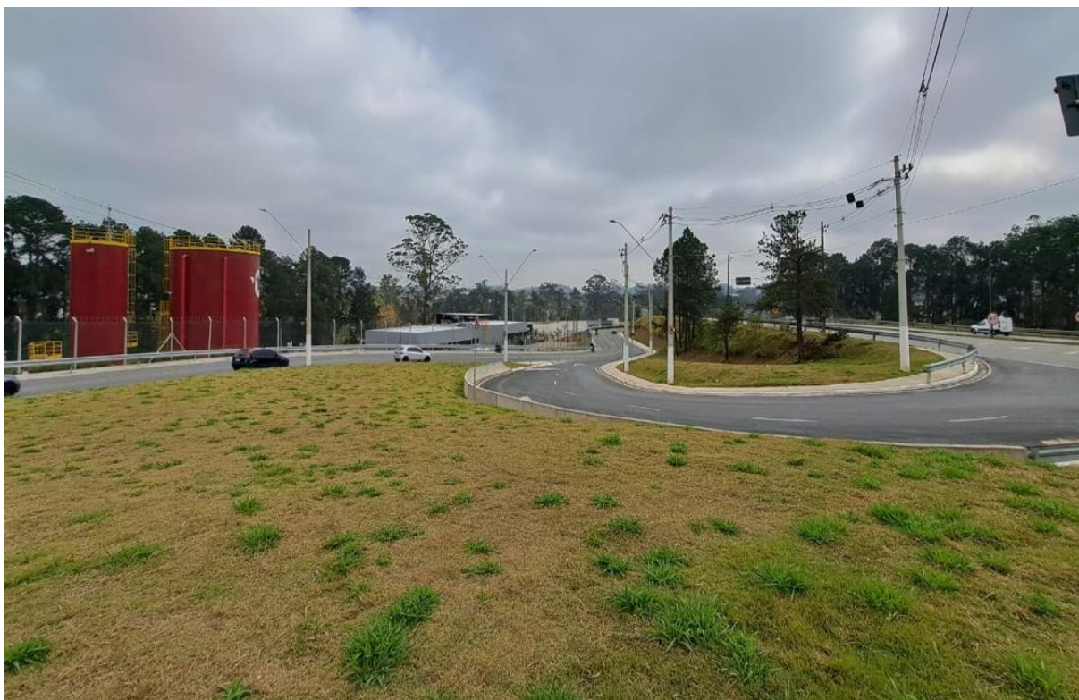
Encaixe do Prolongamento da Rua Santa Martins x Estrada Galvão Bueno Monitoramento de Gases do Terminal Grande Alvarenga
