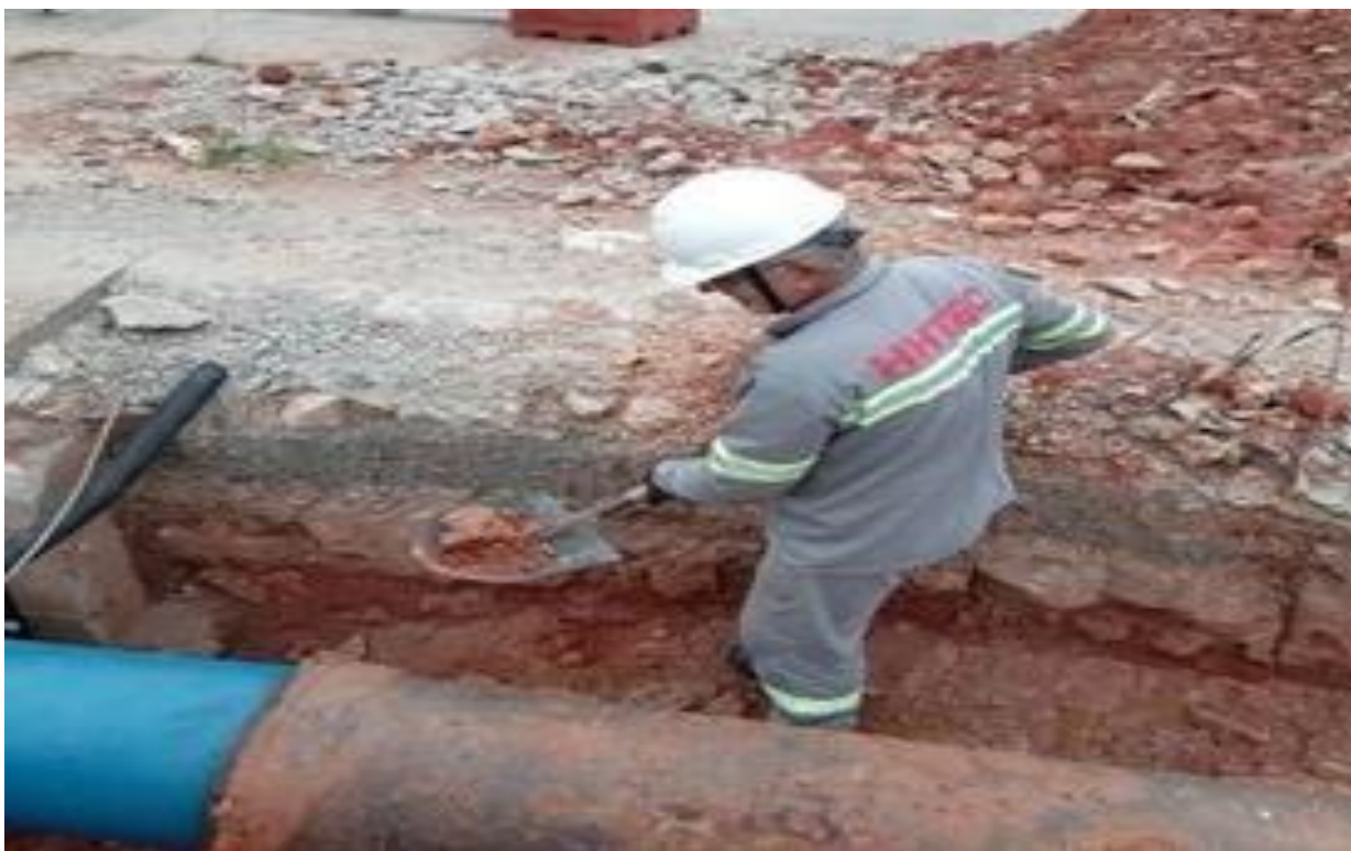
Elevatória Ipiranga Nacional – Manutenção corretiva em tubulação
