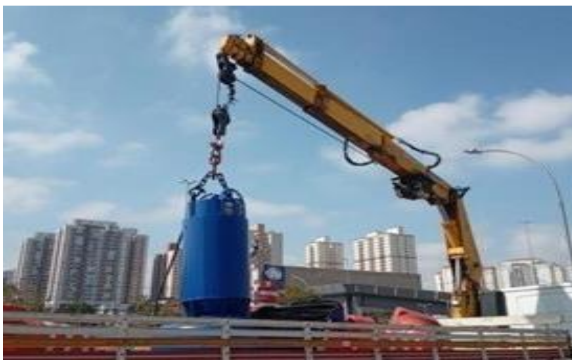
Piscinão do Paço – Manutenção de bomba
