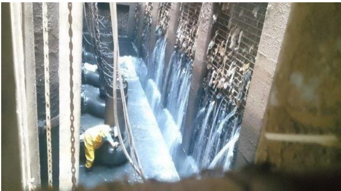
Verificação dos parafusos, das fiações dos motores e fixação das volutas das bombas Fotos dos Serviços Executados no Terceiro Quadrimestre de 2025
