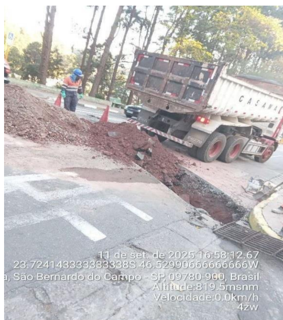
Rua Tiradentes – Manutenção em sarjetão
