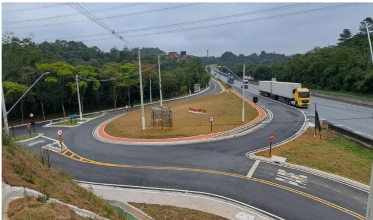
Dispositivo de Saída da Via Anchieta Km.31 – Riacho Grande já em funcionamento Modernização e Ampliação do Sistema Viário Municipal
