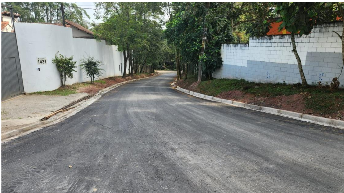
Pavimentação Rua Elizabeth Lobo Garcia – Jd.Las Palmas
