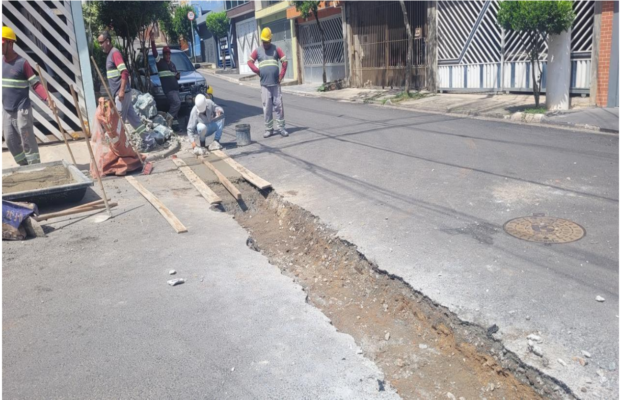
Implantação de Sarjetão no cruzamento das R.dos Portugueses x R.dos Alemães – Pq.Bandeirantes
