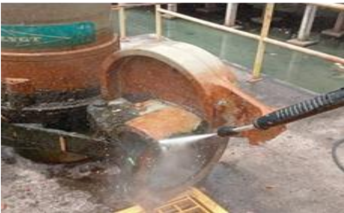
Elevatória Vila Helena – Remoção e limpeza de bomba
