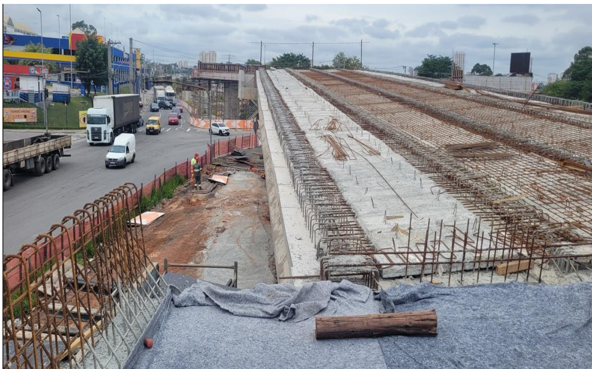
Execução da Estrutura dos Viadutos de ligação da Av.Lions e Corredor ABD 1
