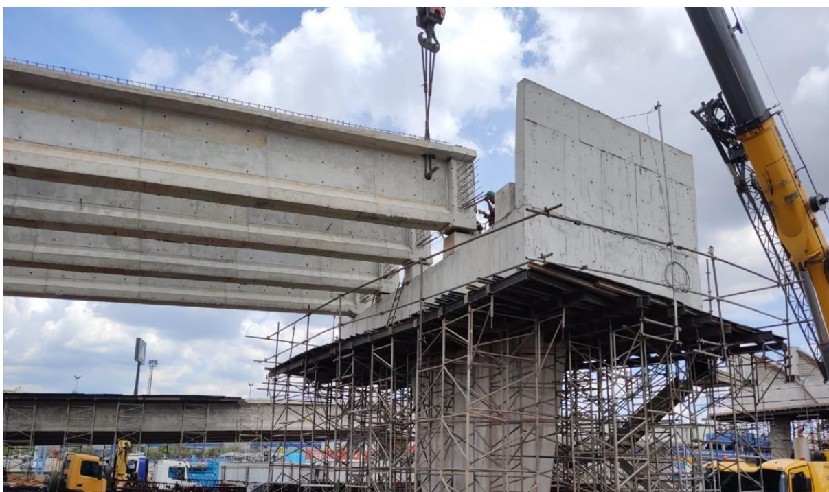
Execução da Estrutura dos Viadutos de ligação da Av.Lions e Corredor ABD 2
