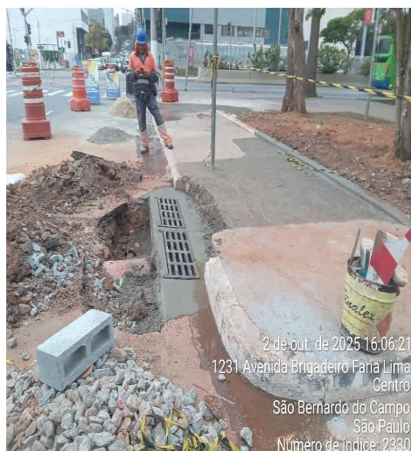
Rua Doutor Flaquer – Recomposição de tubulações comprometidas
