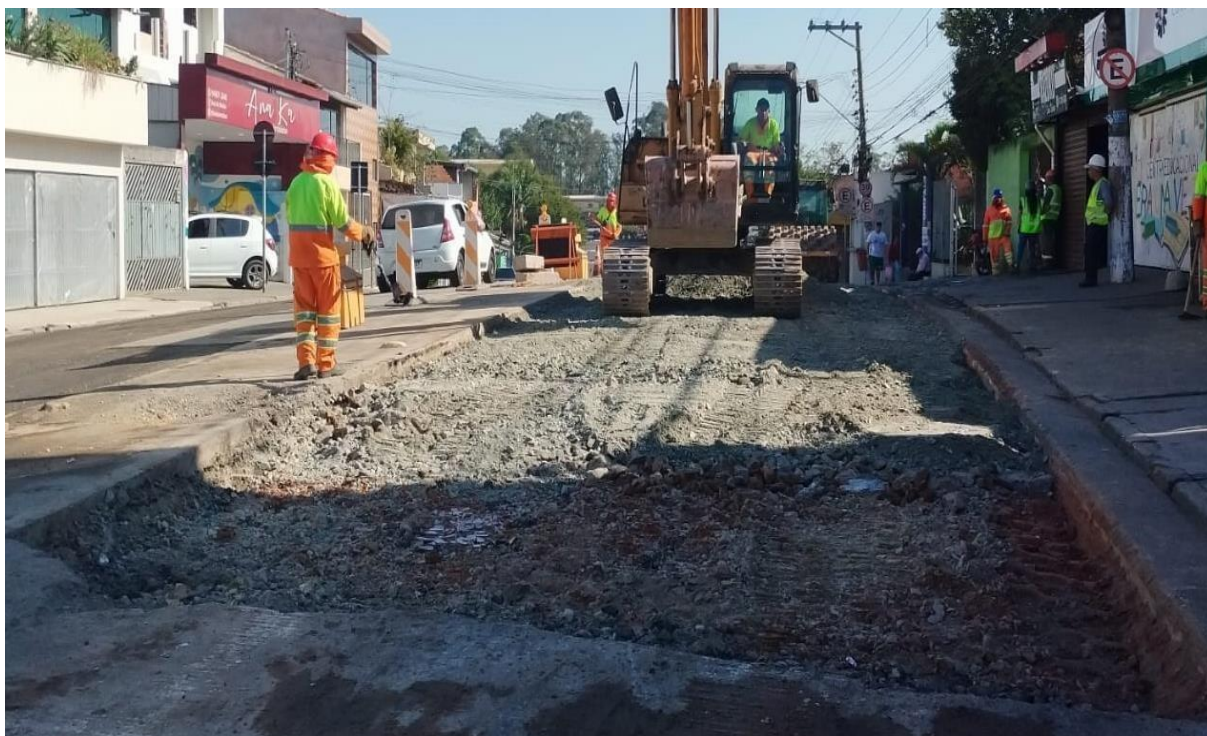
Reforço de Base no pavimento da R.Nossa Senhora de Guadalupe – Jd.das Orquídeas
