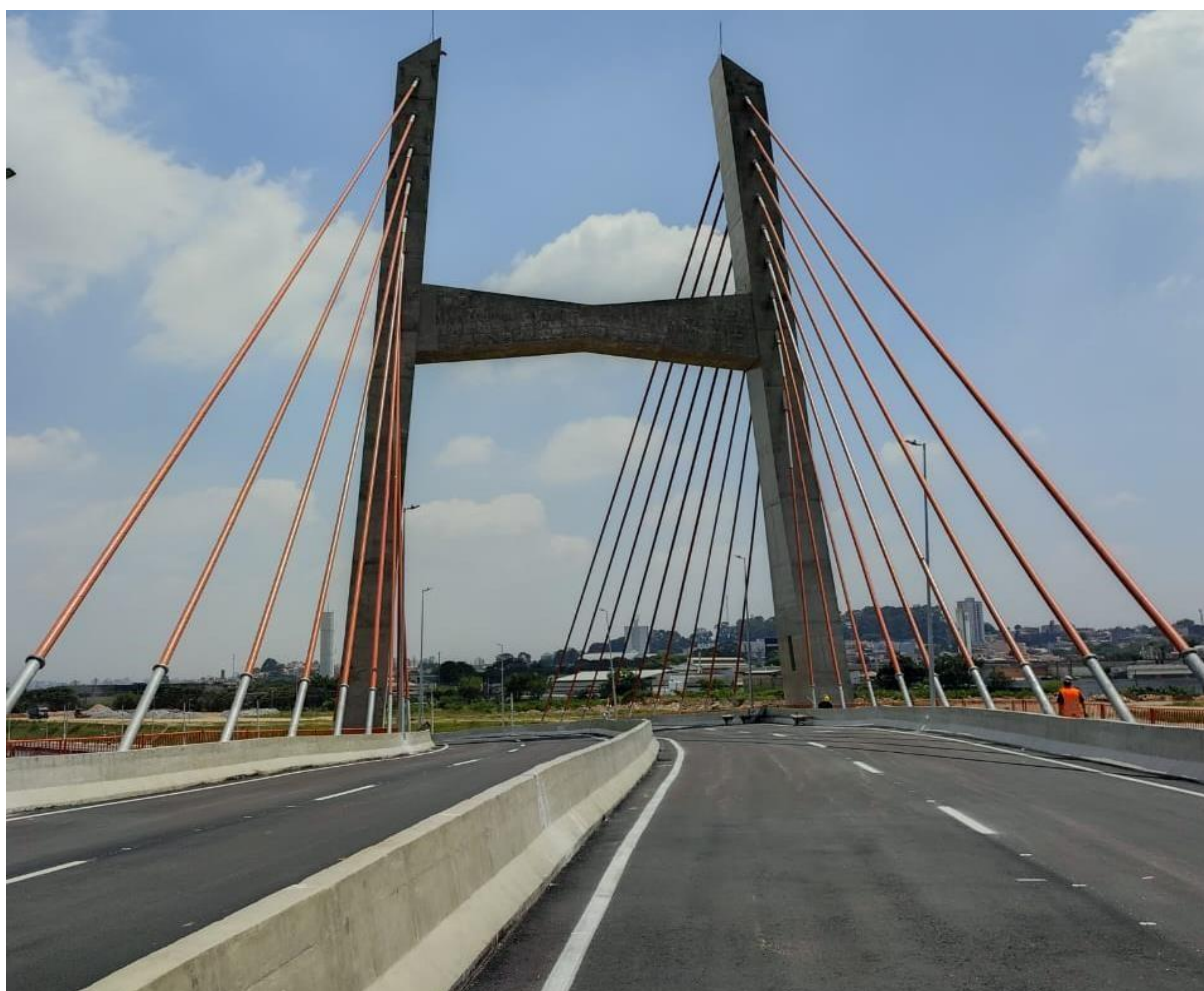
Viaduto Estaiado sobre a Av.Piraporinha
