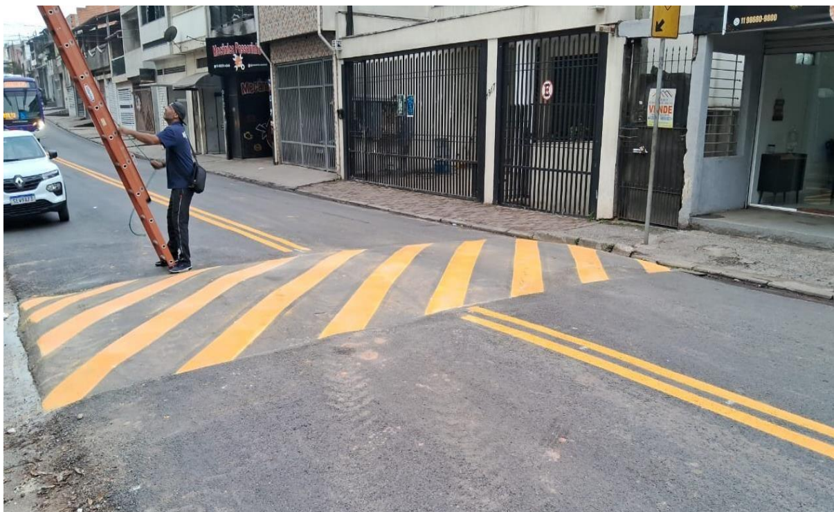
Recapeamento e nova Sinalização Horizontal na Rua Pe.Damião – Jd. das Orquídeas
