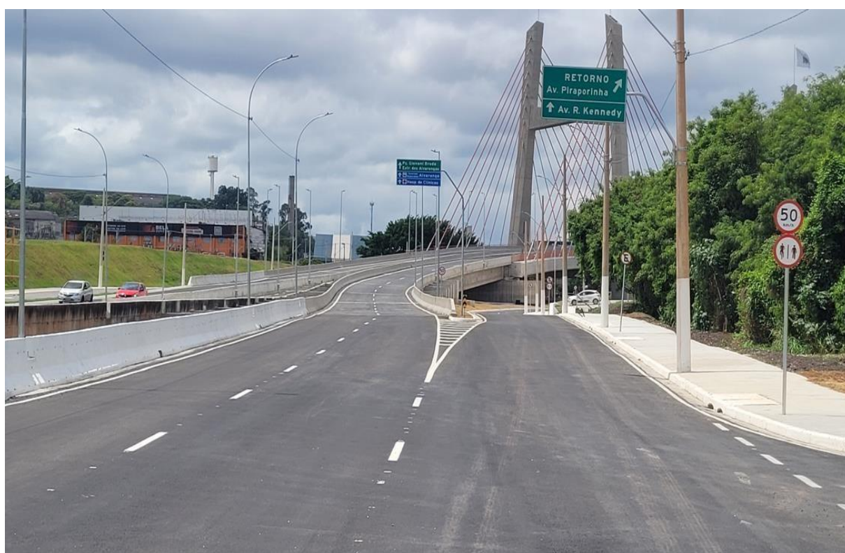
Encaixe da Av.Otávio Manente e o novo Viaduto Estaiado, pista sentido B.Assunção
