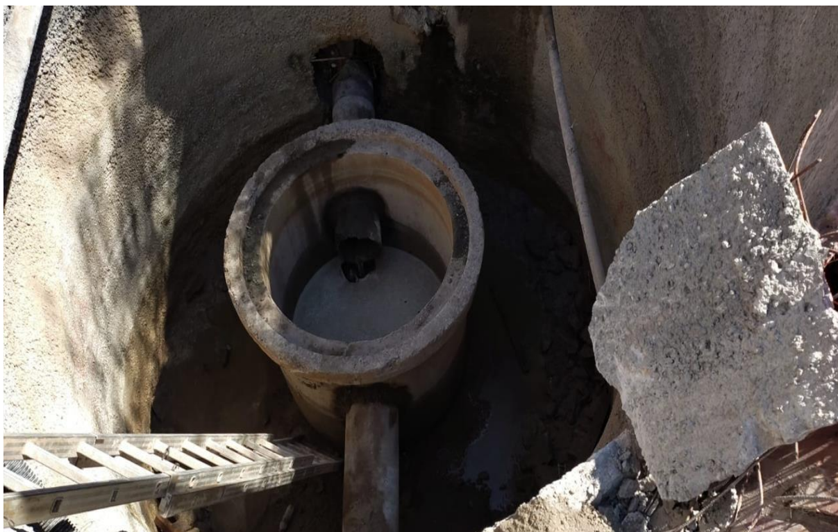
Execução de PV de Esgoto na Rua Neci Eloi Dantas
