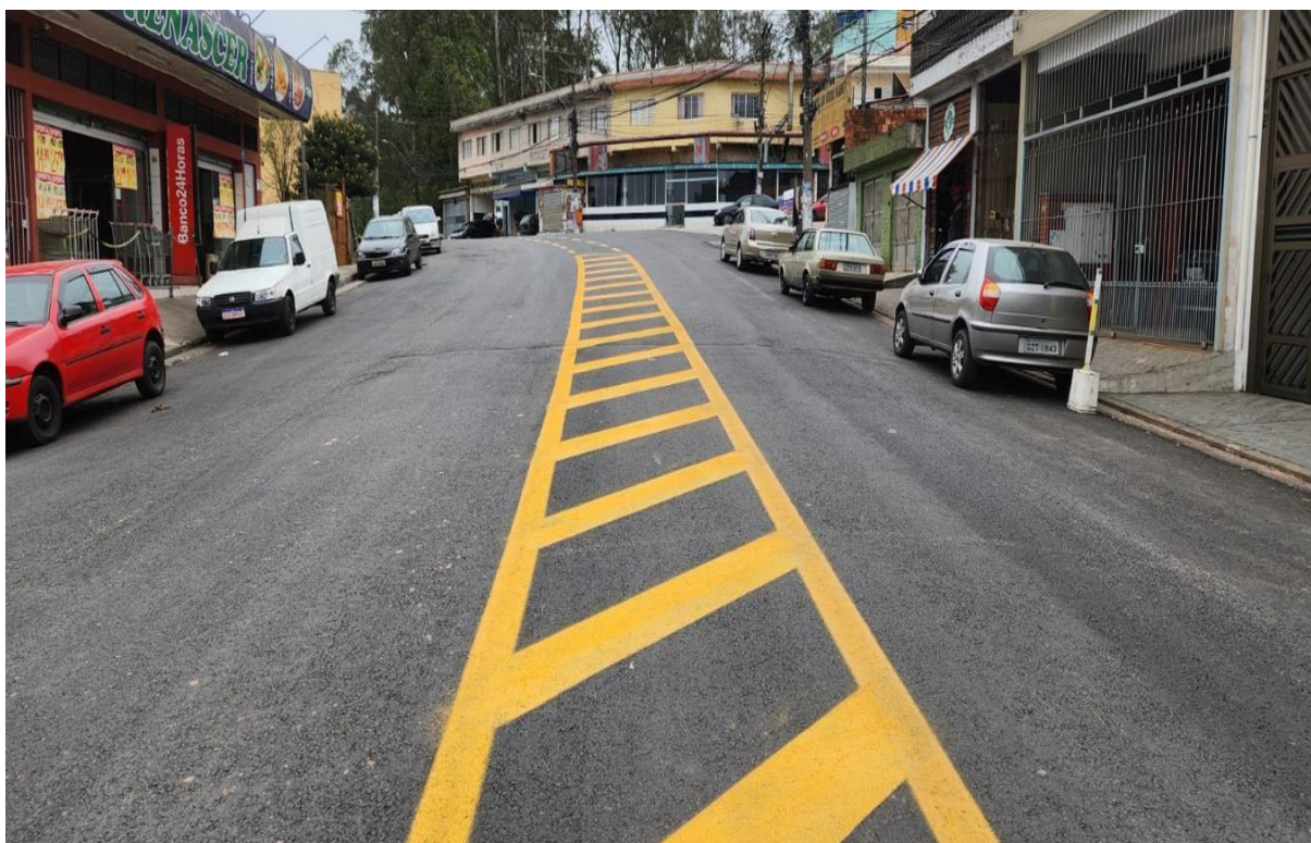
Recapeamento e nova Sinalização Horizontal na Estrada do Poney Club
