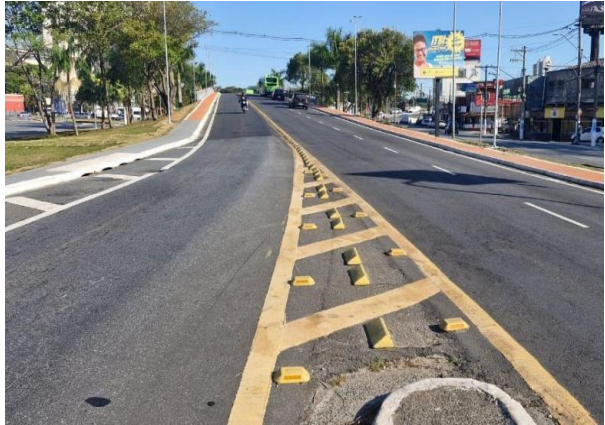
Av. Brig. Faria Lima – Bairro Centro
