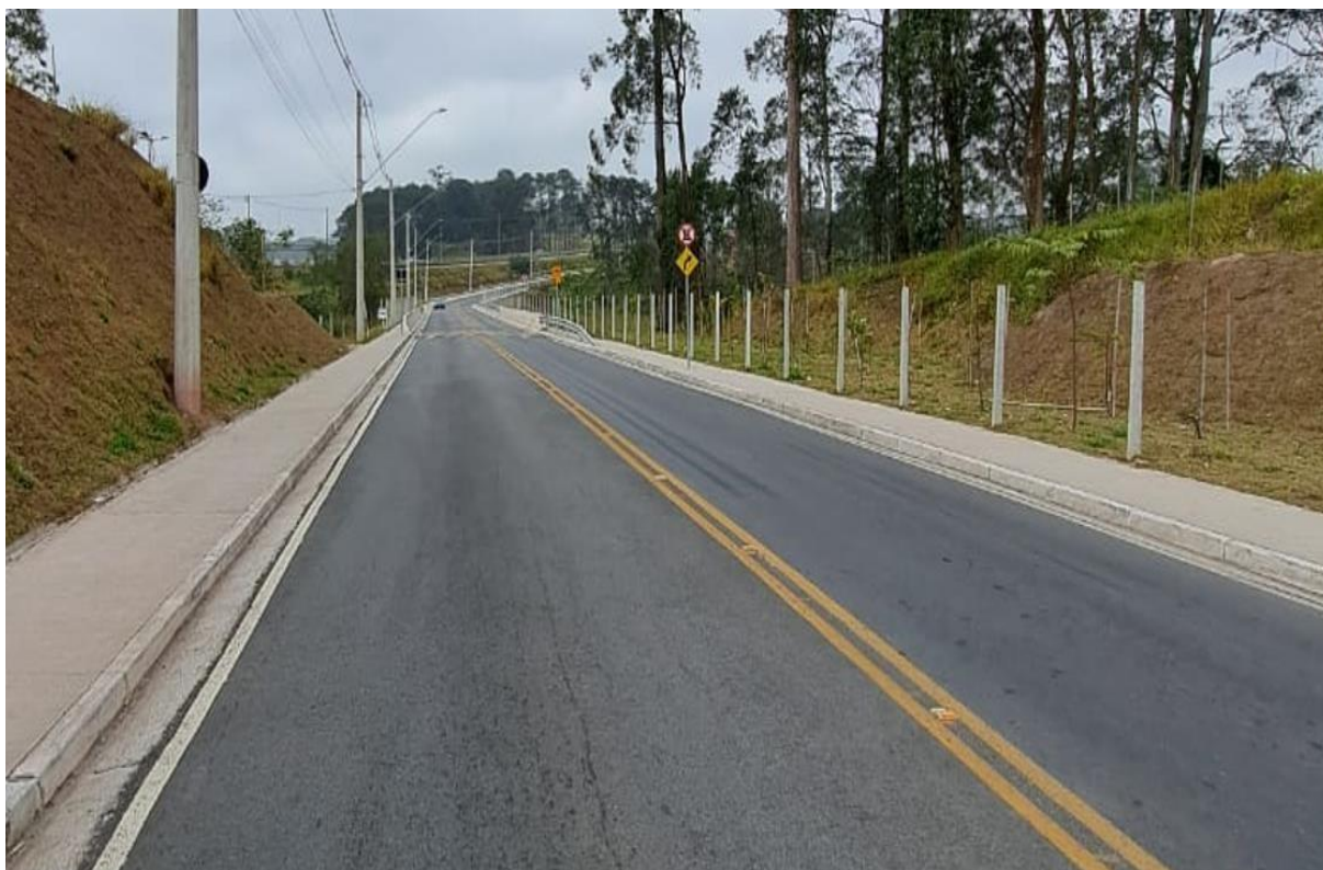
Binário do prolongamento da Rua Santa Martins (2)
