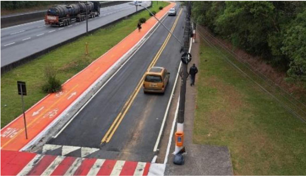
Vista da Rua José, após finalização da obra
