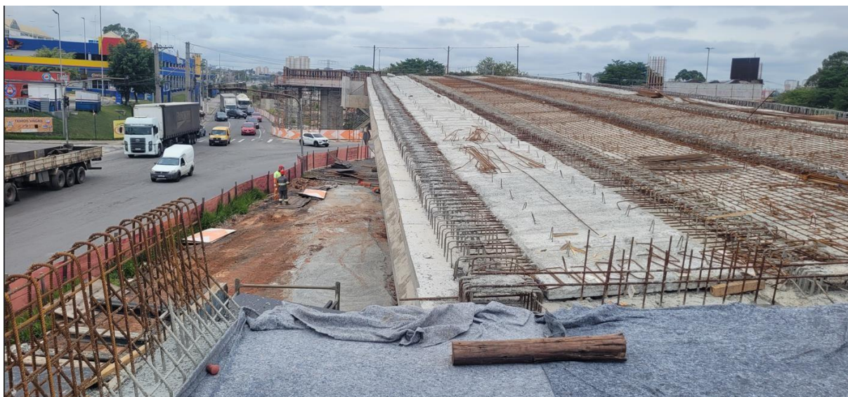
Execução da Estrutura dos Viadutos Viadutos de ligação da Av.Lions e Corredor ABD
