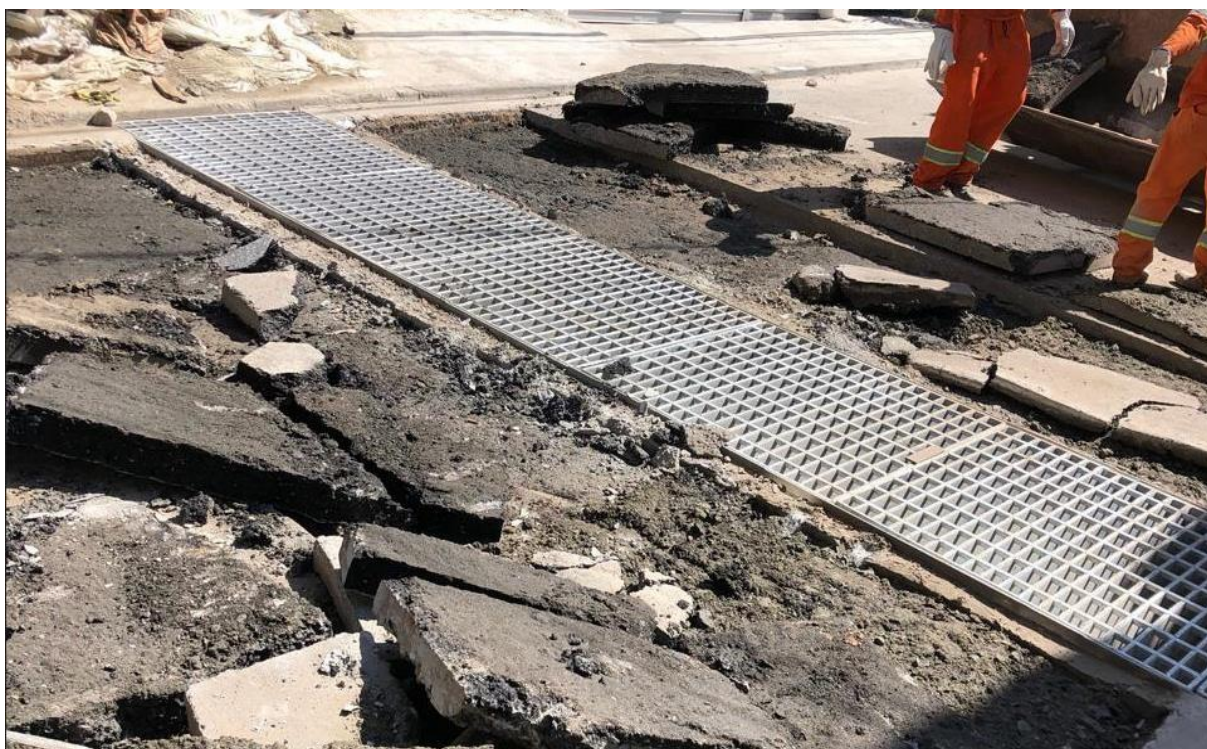
Implantação de Grelha para Drenagem Pluvial
