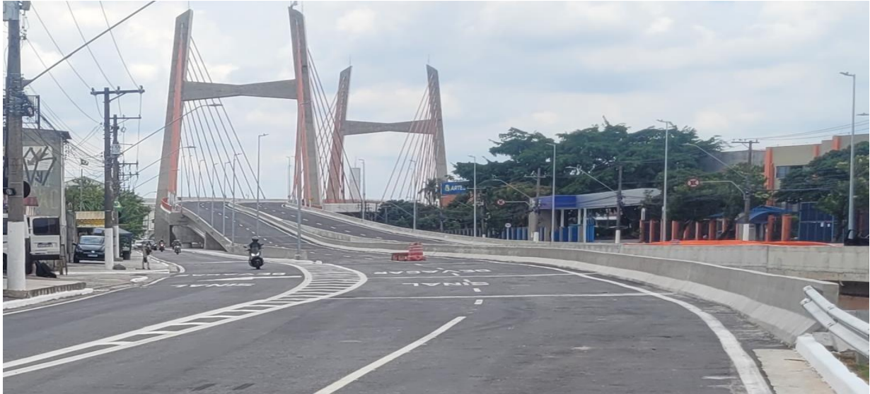
Encaixe da Av.Robert Kennedy e o novo Viaduto Estaiado, pista sentido B.Assunção
