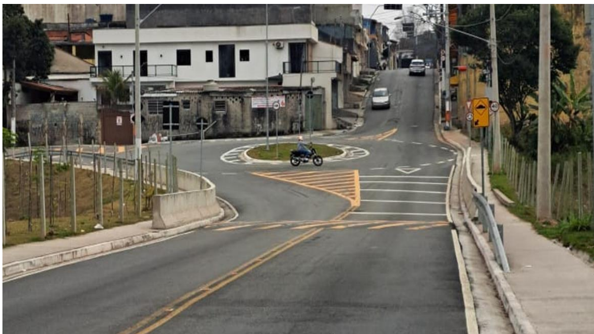
Binário do prolongamento da Rua Santa Martins (1)
