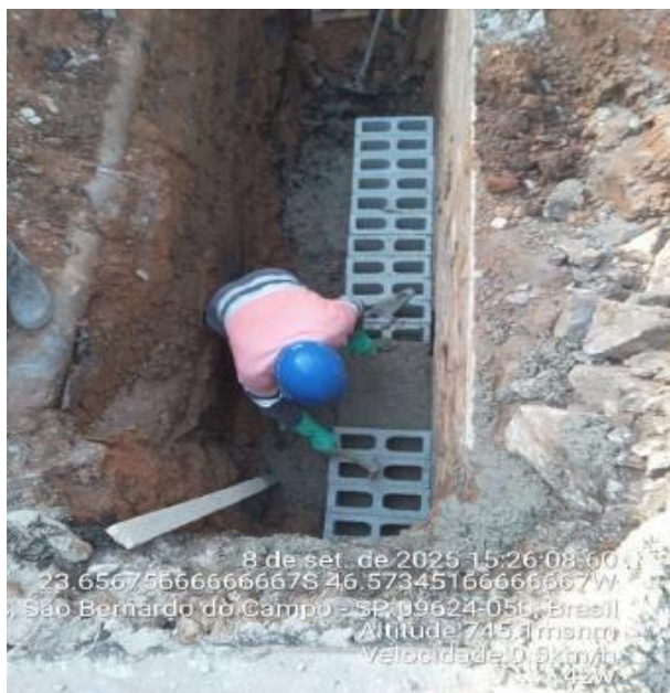
Rua Vitória Régia – Execução de PV
