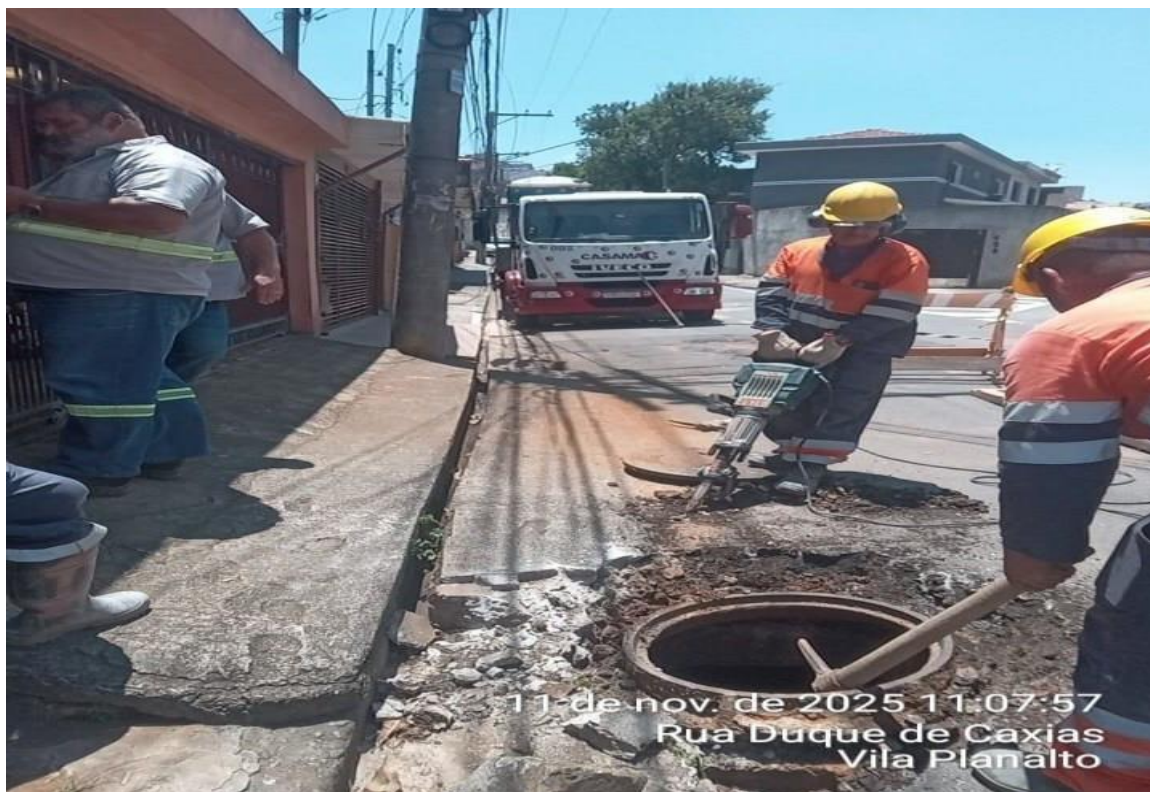
Avenida João Firmino – Manutenção em PV e sarjeta
