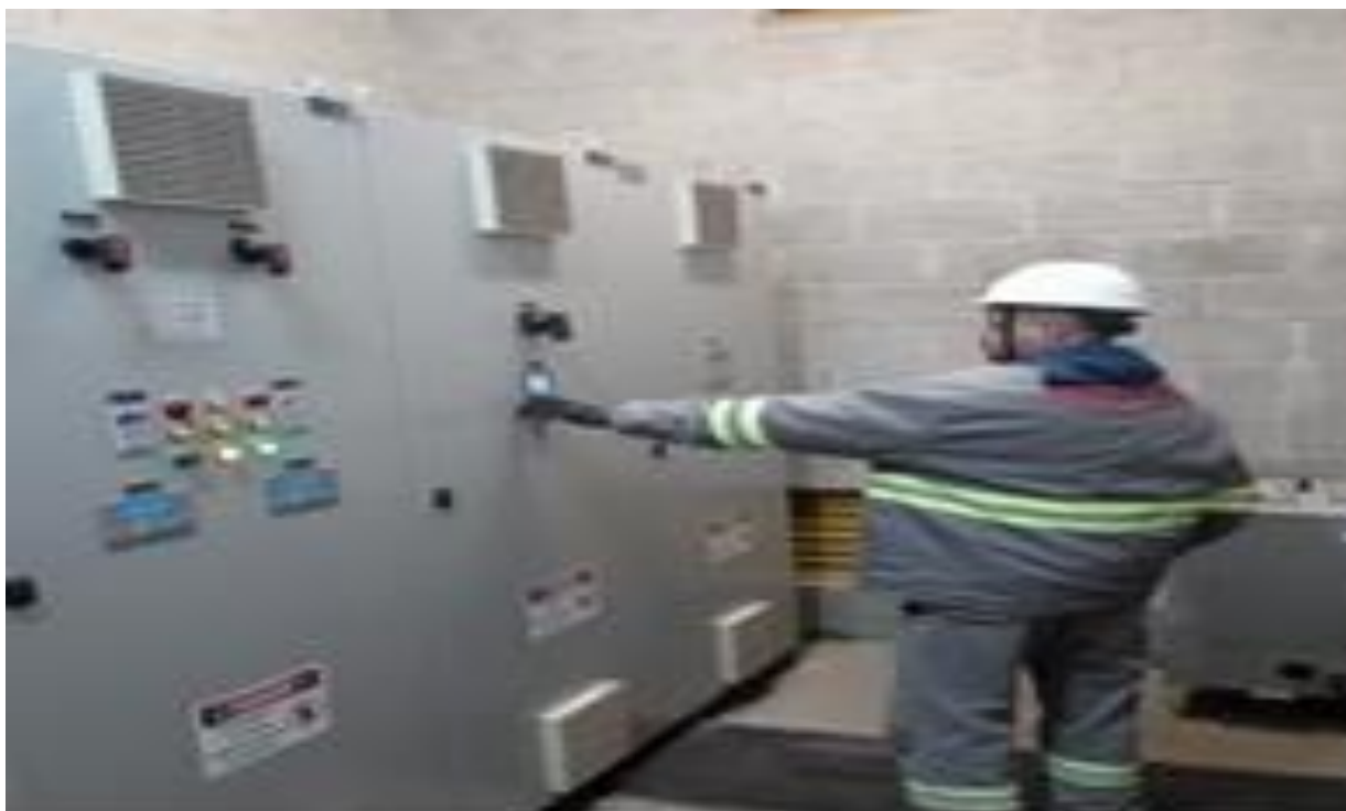
Elevatória Vila Helena – Inspeção e manutenção preventiva de Quadro Elétrico
