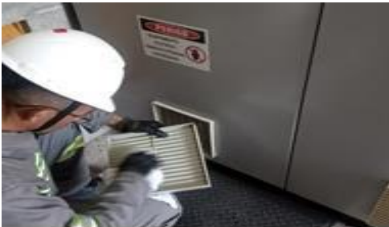
Elevatória Ipiranga Nacional – Limpeza periódica de equipamentos
