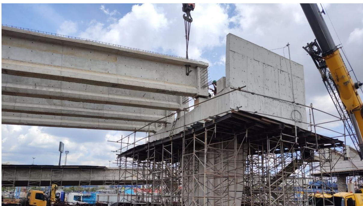
Execução da Estrutura dos Viadutos Viadutos de ligação da Av.Lions e Corredor ABD (2)
