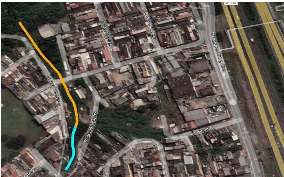
Trecho canalizado – BAL-12
