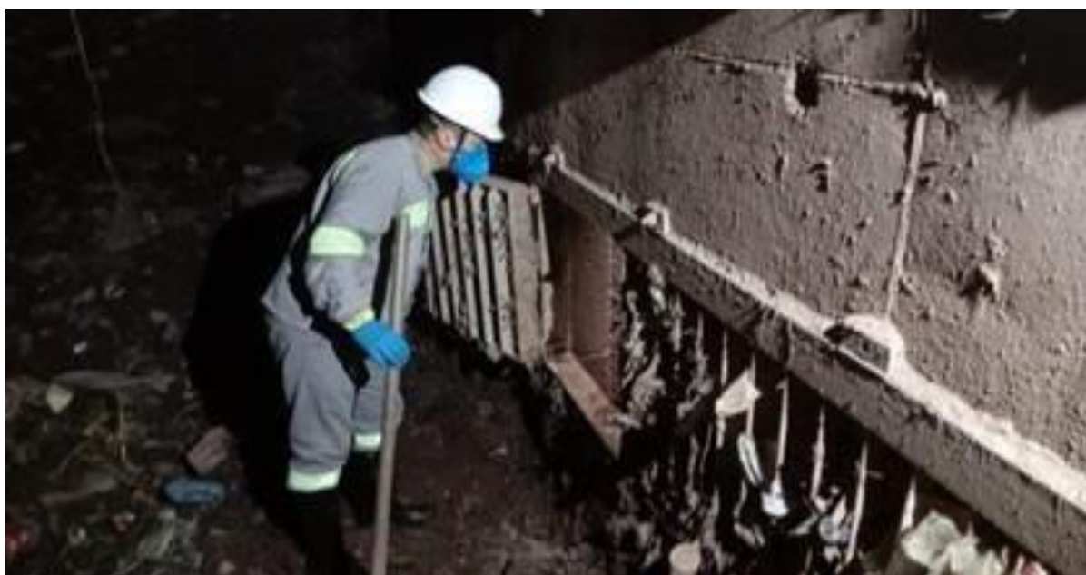
Piscinão do Paço – Limpeza portinhola que do acesso as bombas do reservatório para instalação do sensor e controlador de nível
