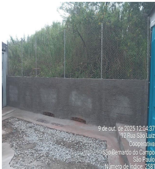
Rua São Luiz – Recomposição de captação captação e tubulações comprometidas
