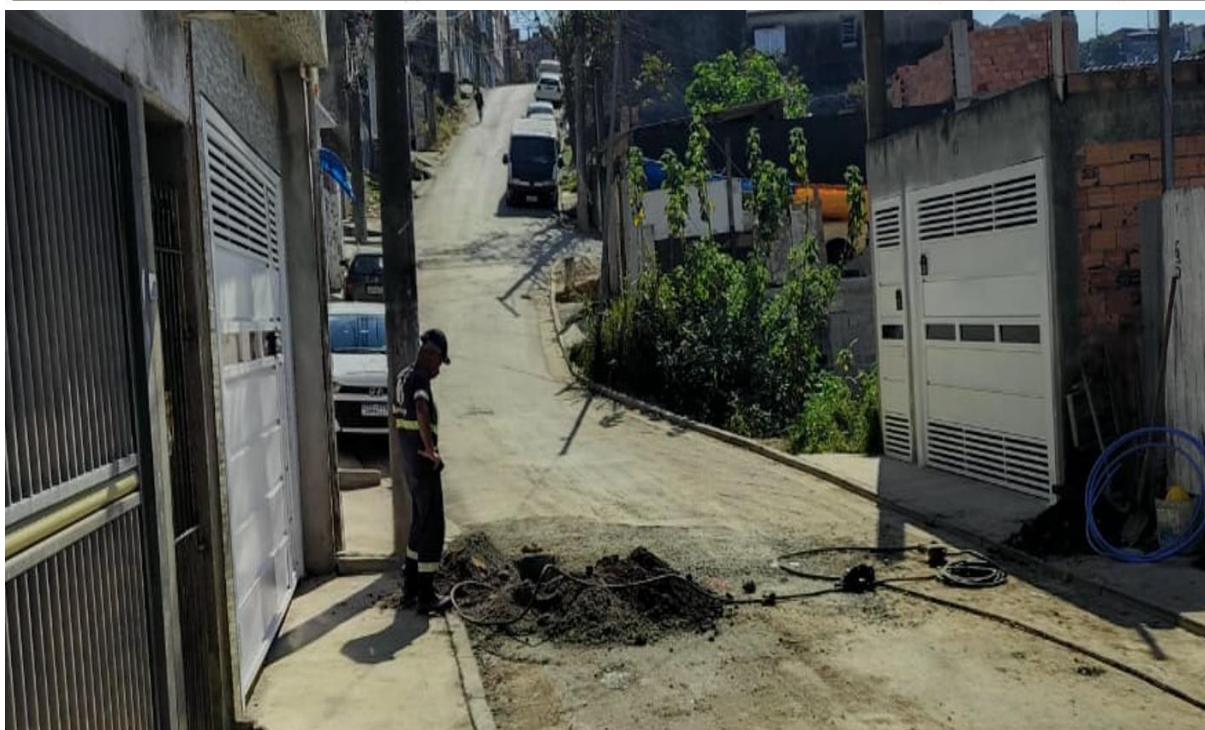
Implantação de Rede de Água Potável na Rua das Laranjeiras
