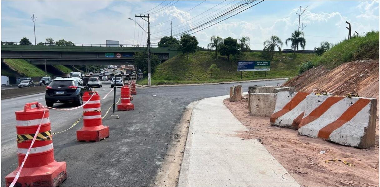
Encaixe entre a Av.Lions e a Alça de acesso à Via Anchieta
