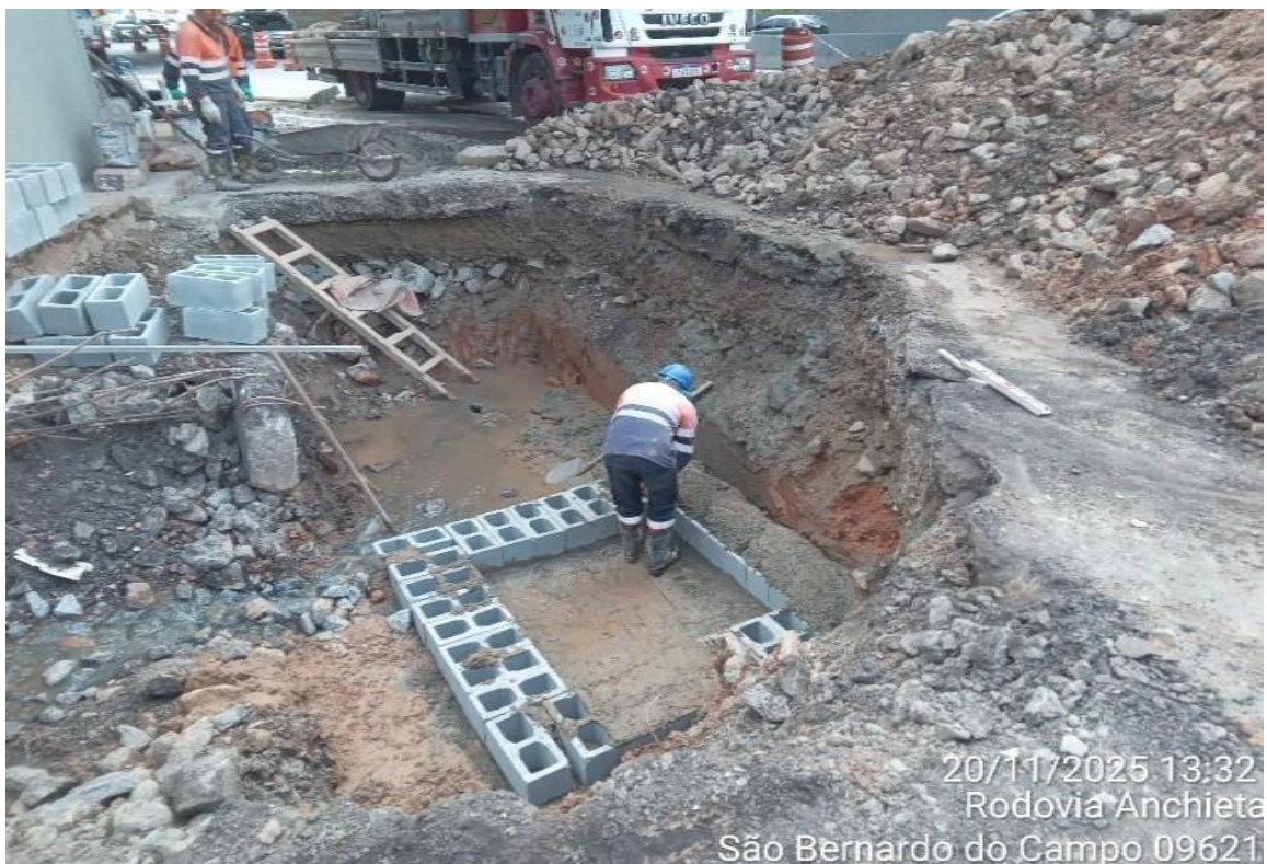
Avenida Lions – Manutenção e recomposição de rede de drenagem comprometida
