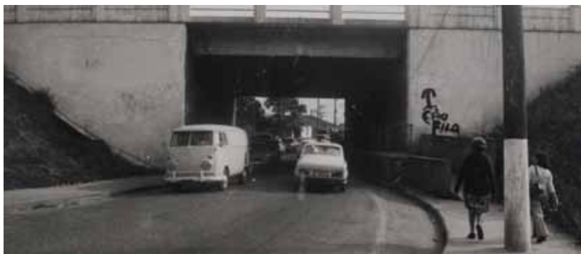
Viaduto do km 22 da Anchieta, início da João Firmino, década de 1970. Acervo Seção de Pesquisa e Documentação (Memória)
