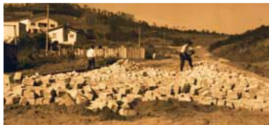
Obras de pavimentação em via do Jardim Silvina. 1996. Acervo: Seção de Pesquisa e Documentação
