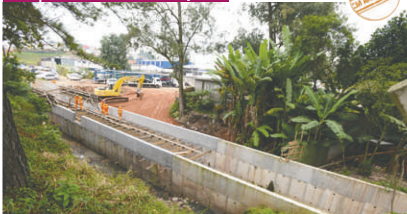
OBRA PARA CANALIZAÇÃO DO CÓRREGO CAPUAVA
