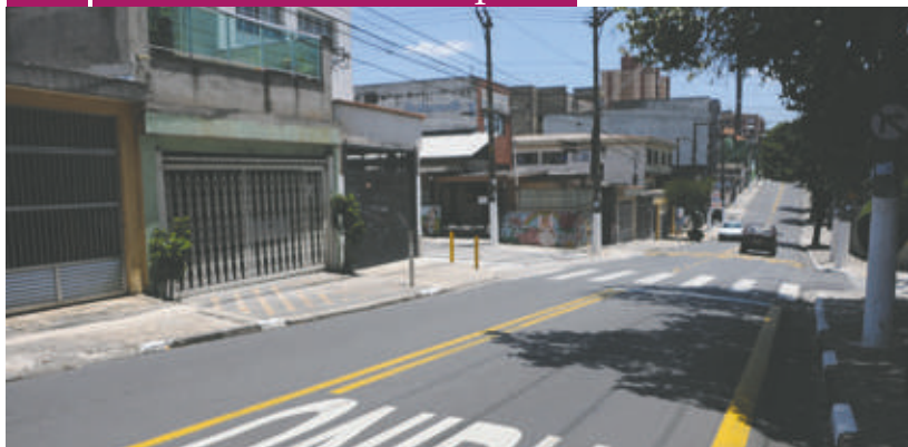
RECAPEAMENTO DA RUA MMDC, NA VILA PAULICÉIA
