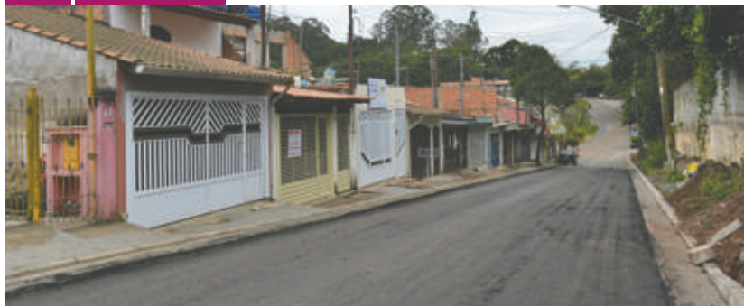
PAVIMENTAÇÃO DE RUAS DO BAIRRO ROYAL PARK
