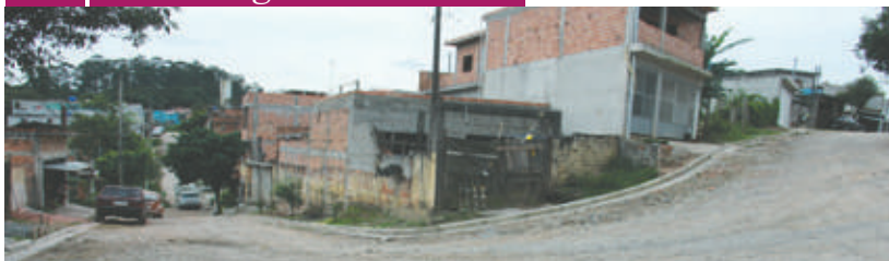
GUIAS E SARJETAS NO PARQUE DOS QUÍMICOS
