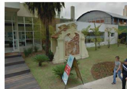
Foto 18 - Face do empreendimento imobiliário em construção. Fonte: Google Earth, 2011.
