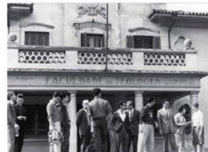
Foto 5 - Fachada do Edifício Alfa da Faculdade de Teologia em 1969. Fonte: MÉDICE, 2012.
