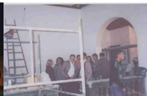
Foto 20 - A capela em obras de reconstrução após o incêndio de 1999. Fonte: Prefeitura Municipal de São Bernardo do Campo (1999).
