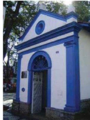
Foto 29 - Fachada da Capela de Nossa Senhora da Boa Viagem em 2009. Fonte: PMSBC (2009).
