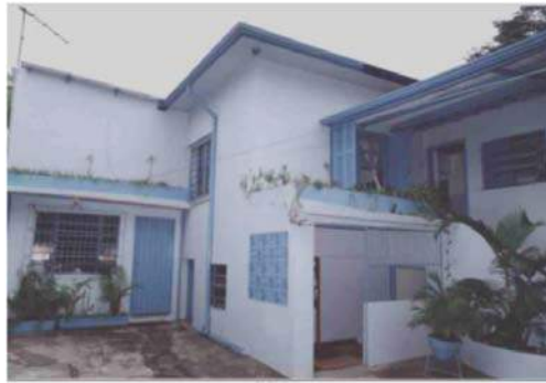
Foto 22 - Vista interior da antiga Escola Municipal de Ensino Básico Santa Terezinha.
