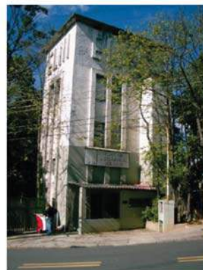
Foto 15 - Torre de sustentação do reservatório de água da antiga empresa de têxteis ELNI. Fonte: Prefeitura Municipal de São Bernardo do Campo, 2001.
