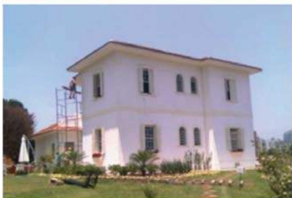
Foto 34 - Casa do Comissário do Café passa por reforma em 2009. Atualmente o prédio é utilizado com instituto educacional. Fonte: PMSBC.
