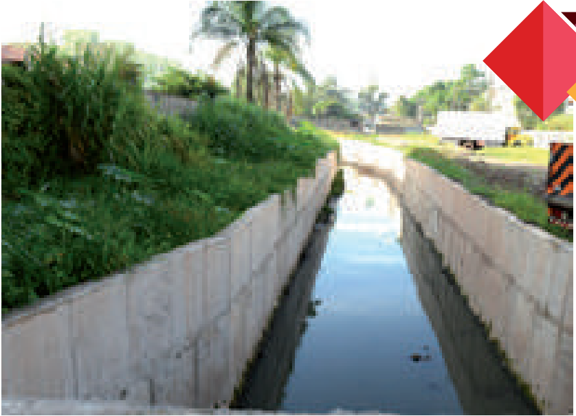
Canalização do Córrego Capuava
