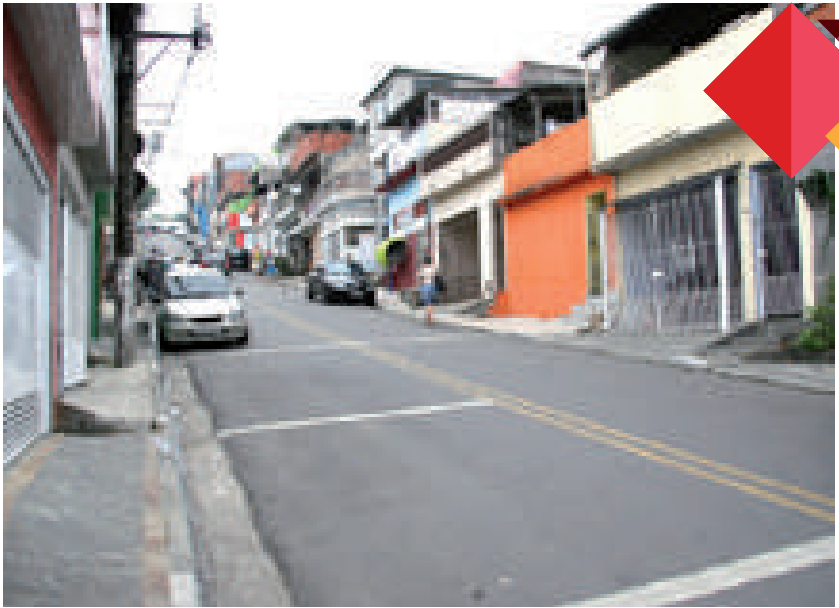
Pavimentação da Rua Principal Divinéia
