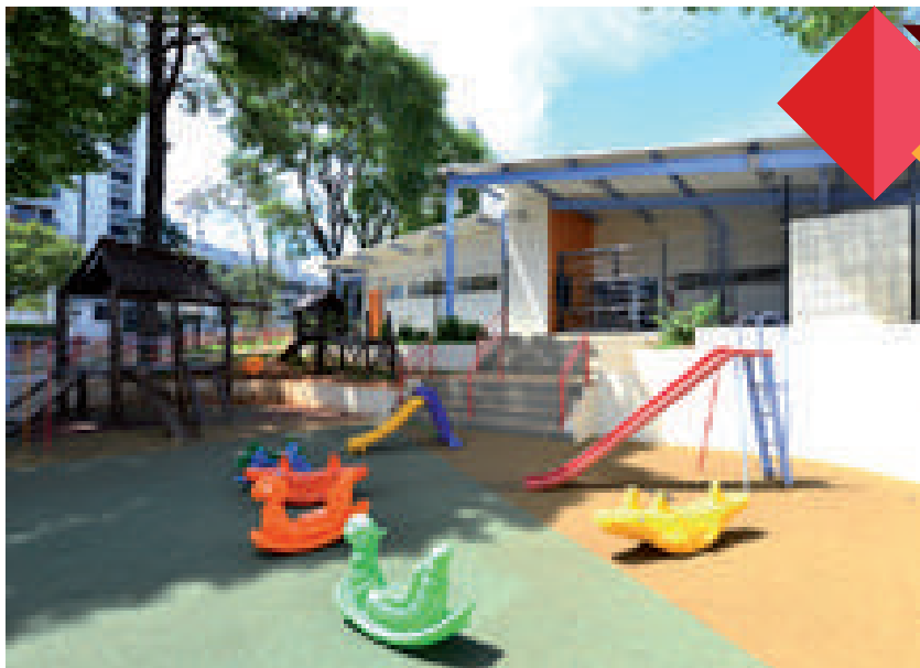
Reforma e ampliação da Emeb Vinicius de Moraes
