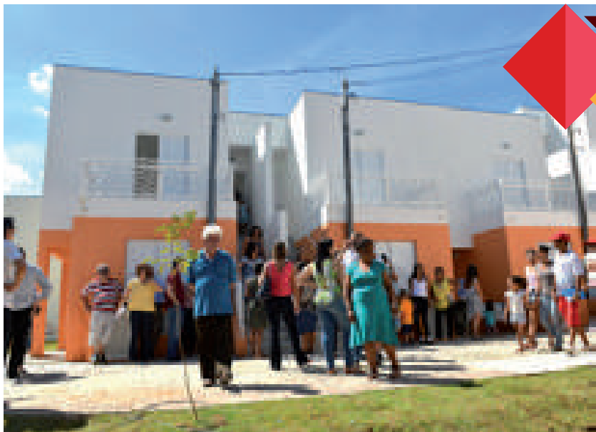
Obra de urbanização do Jardim Capelinha e Cocaia
