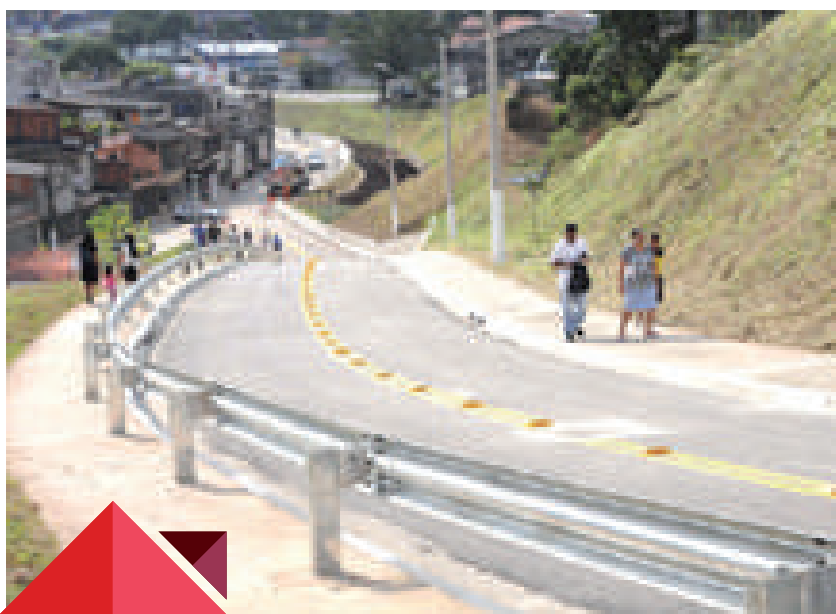
Novo acesso para o Bairro Golden Park
