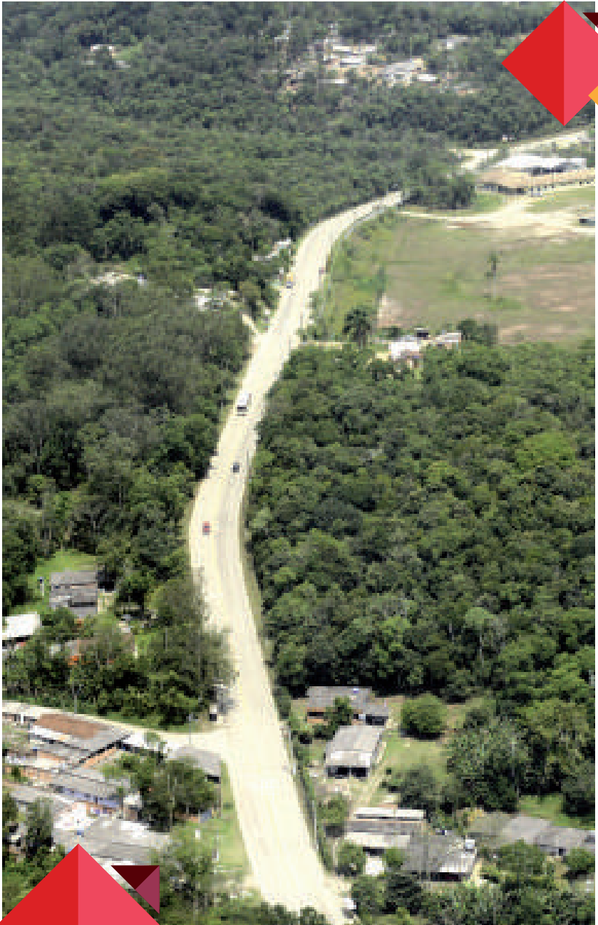
Revitalização da Estrada do Rio Acima
