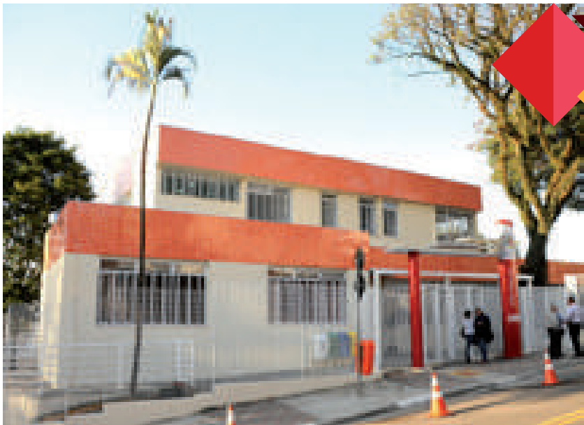
Reforma e ampliação da Unidade de Saúde da Vila Marchi
