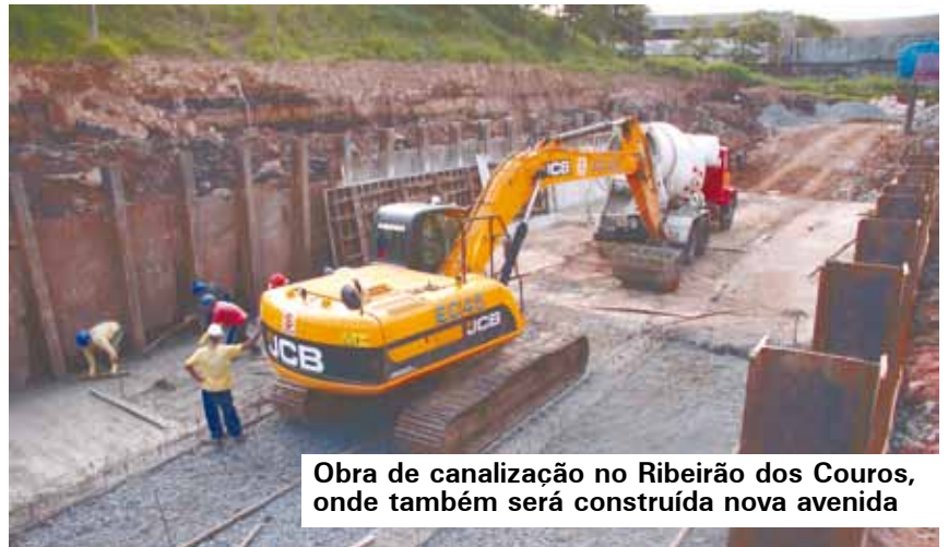
Trecho do Córrego dos Alvarenga onde a obra está finalizada
