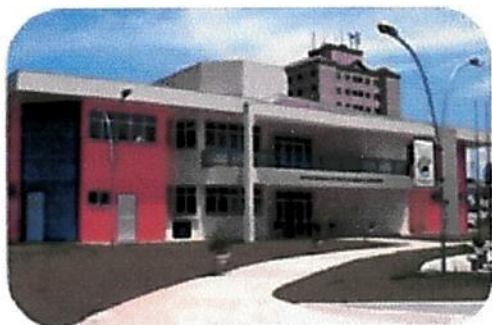
Fachada do prédio do Centro de Referência famílias.
