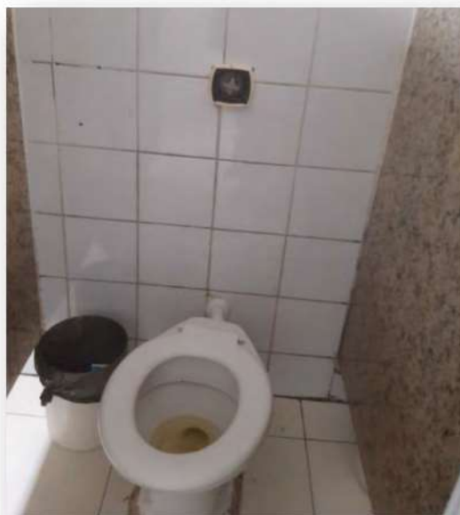
Vaso sanitário sem a tampa do assento e sem a tampa frontal para válvula de descarga
