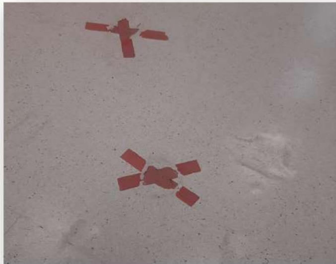
Foto 16 - Afundamento do piso 7º andar
