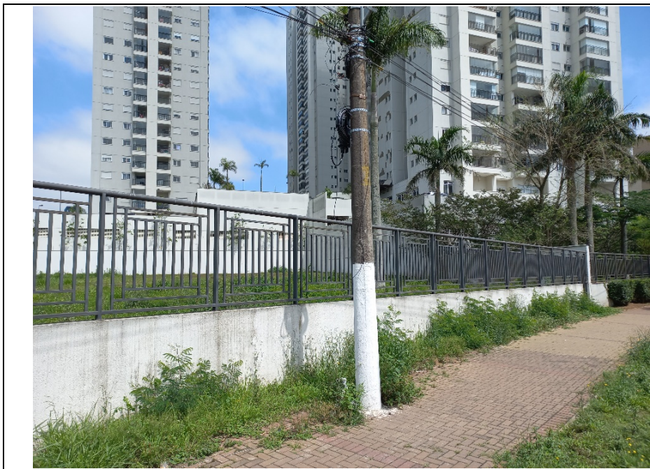
Foto 1: Vista do terreno, acesso Av. Robert Kennedy
