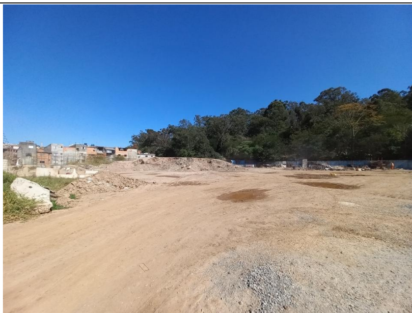
Foto 1: Vista para o Campo de Futebol pela Avenida Luiz Pequini e o Pq. Chácara Silvestre aos fundos
