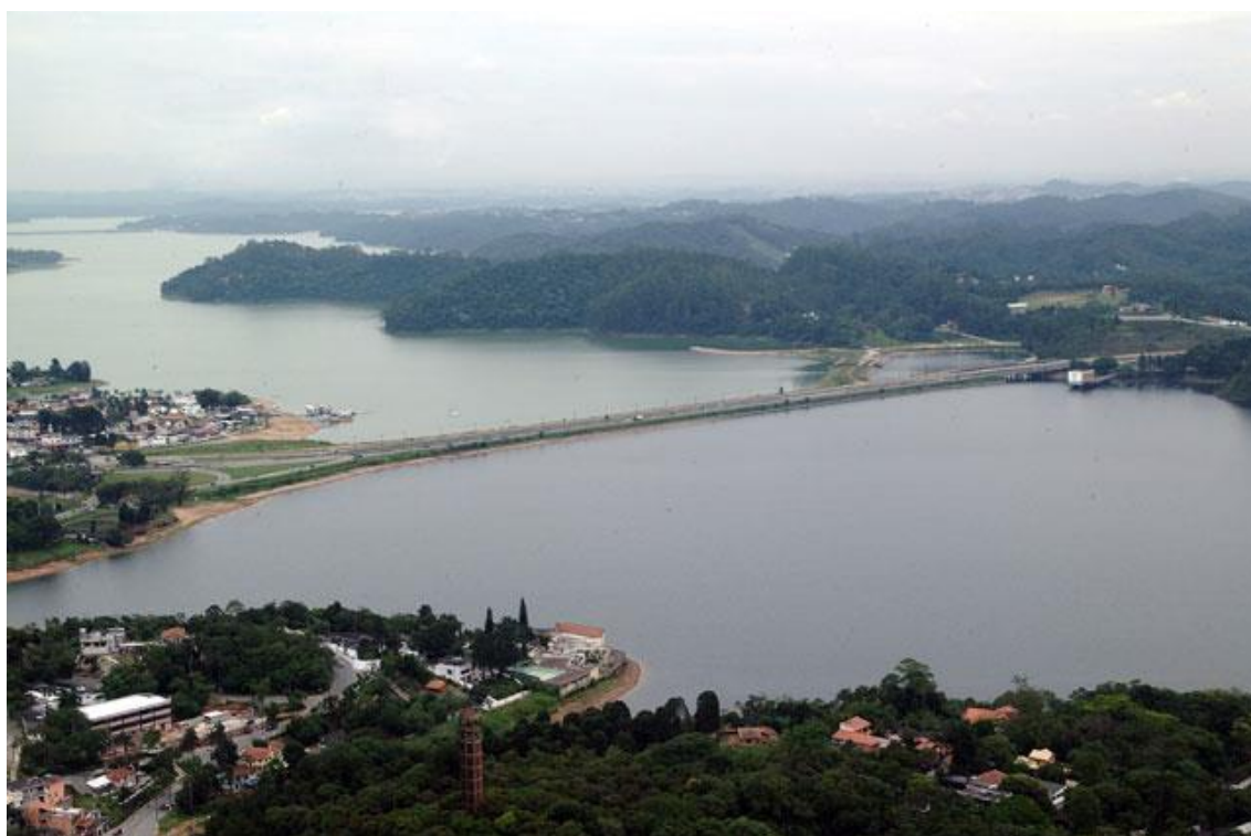
Figura 1 - Foto área oblíqua do Braço do Rio Grande, reservatório Billings, onde ocorre a captação de água para abastecimento público
