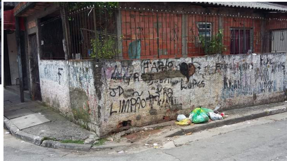
- Calçada para a qual foi solicitado reparo e conservação
